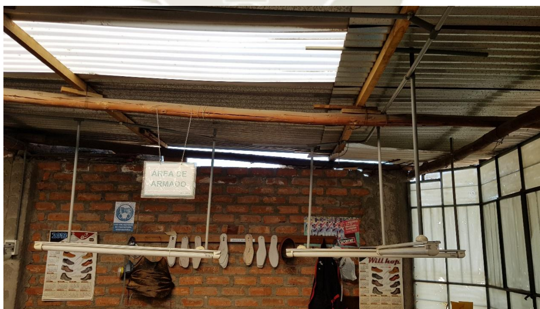
Figura 36: Techo de calaminas
