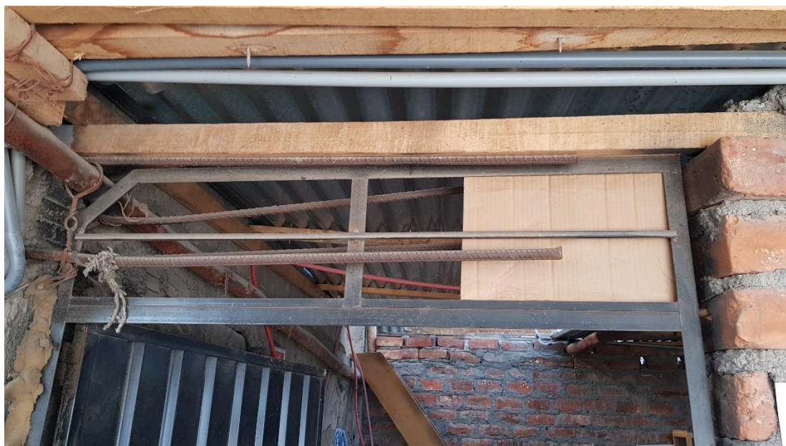
Figura 35: Ventana dentro del área del cortado
