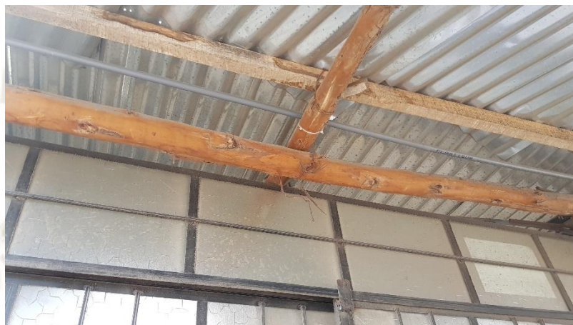
Figura 37: Ventanas y huecos en los techos
