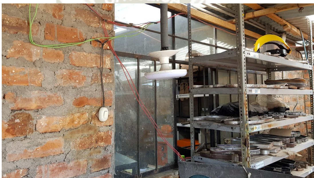
Figura 34: Ladrillos en la construcción de la empresa
