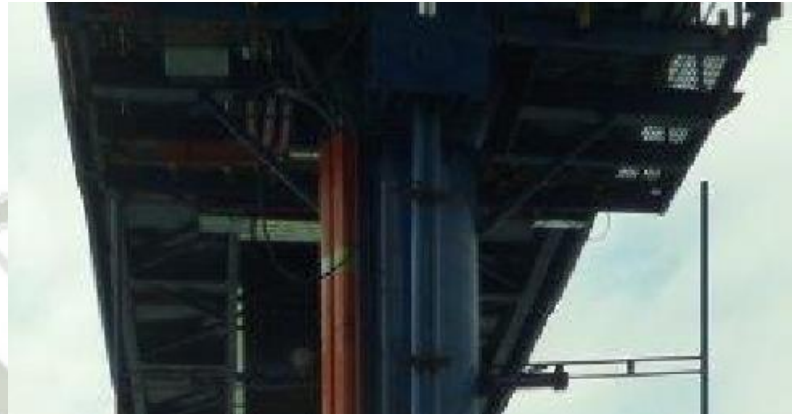
Fotografía 3.7: Chute de Descarga
