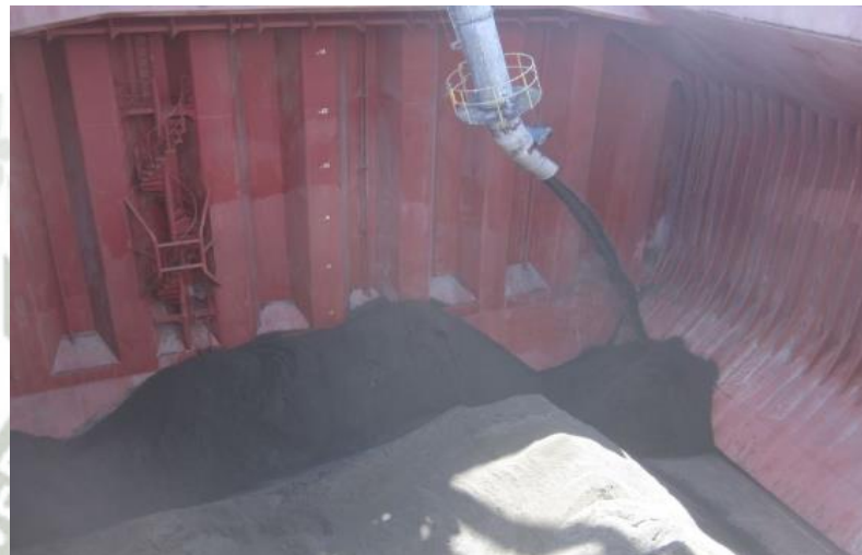
Fotografía 3.8: Funcionamiento del Sistema de Giro (Fuente: Área de Mantenimiento, Tisur – Ingeniería)
