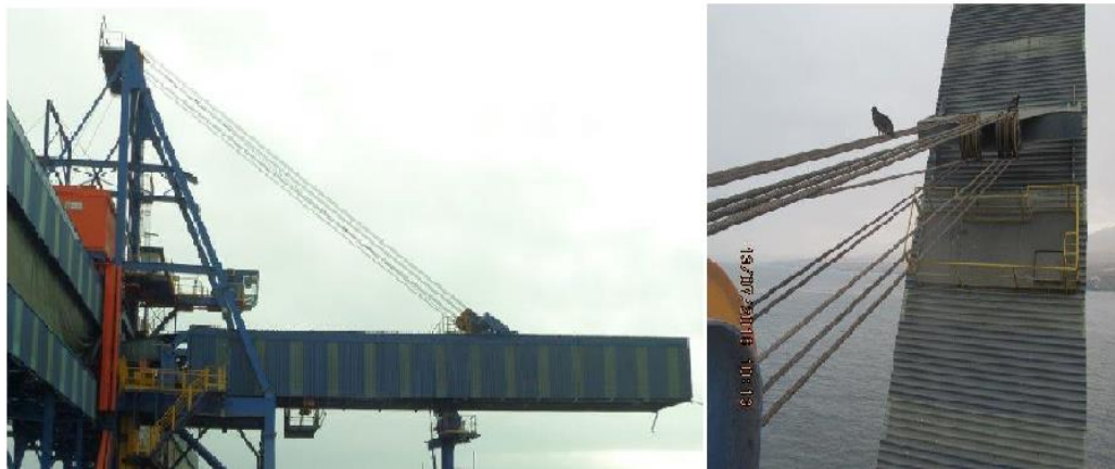
Fotografía 3.4: Sistema de Levante del Shiploader (Fuente: Área de Mantenimiento, Tisur - Ingeniería)
