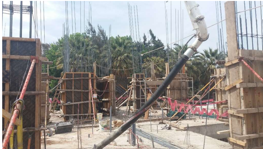
Figura 37: Encofrado y vaciado de columnas y placas 4to Nivel, Residencial Palermo (Fuente: Propia)
