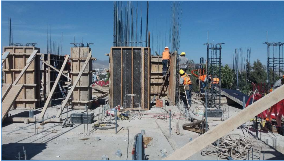
Figura 58: Mano de obra en encofrado de placas y columnas, Obra Residencial Palermo
