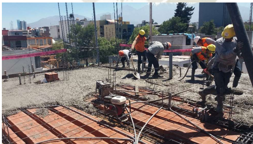
Figura 49: Vaciado de concreto F'c=210 kg/cm 2 en losa y viga 5to piso, Obra Residencial Palermo
