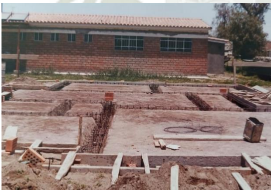
Cimentación para el sistema CAPEX
