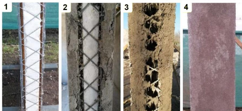
Figura 64 Proceso de revocado por cargas
