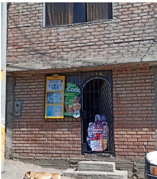
Acabado en ladrillo caravista
