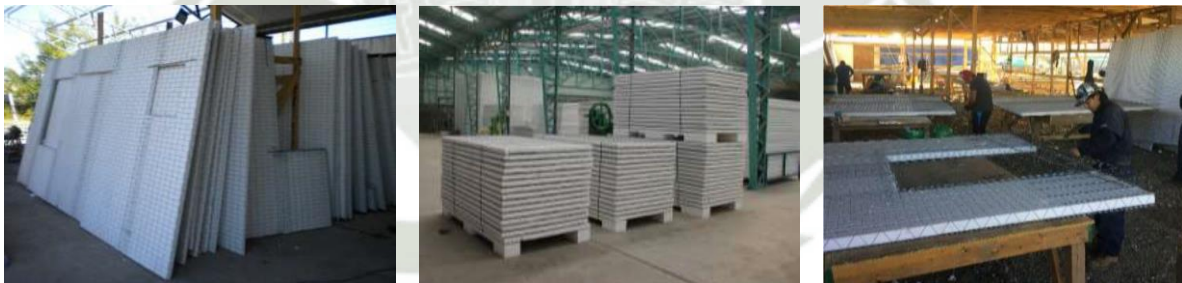
Figura 65 Almacenamiento en obra paneles Covintec
