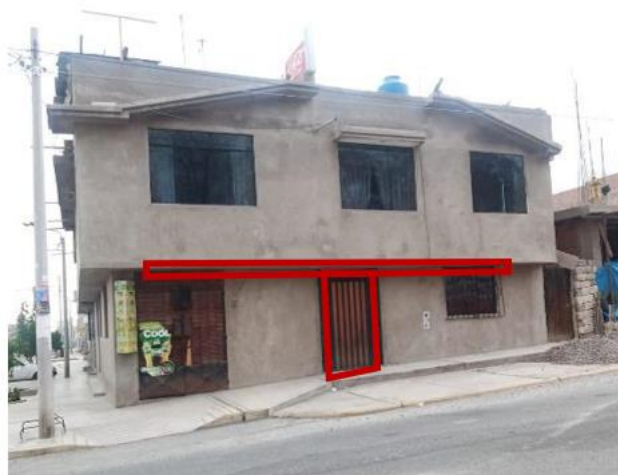
Figura 80 Dintel de refuerzo
