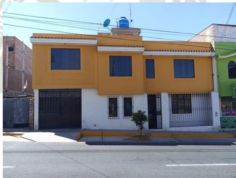
Fachada de vivienda unifamiliar en Albañilería Confinada
