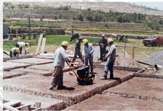
Nivelado de suelo
