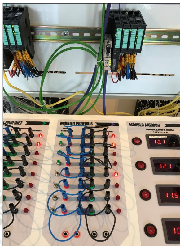
Figura 81. Sección PROFIBUS DP del módulo de automatización en operación.
