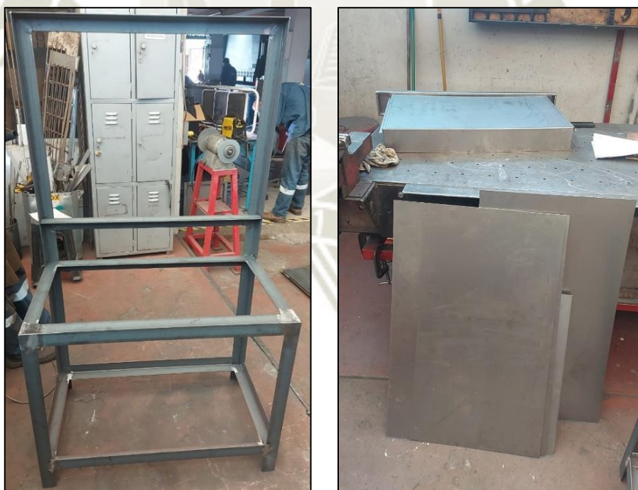
Figura 61. Fabricación del módulo portante
