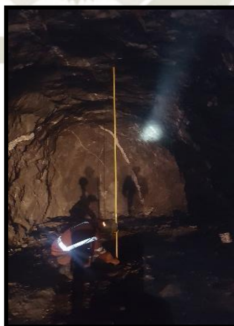
Foto 11: Altura de labor 4.20
