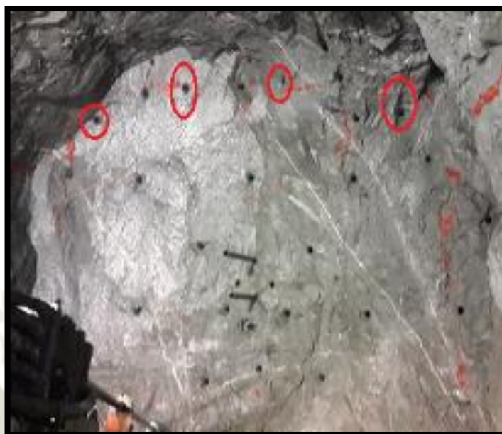
Foto 7: Perforación de taladros de en corona
