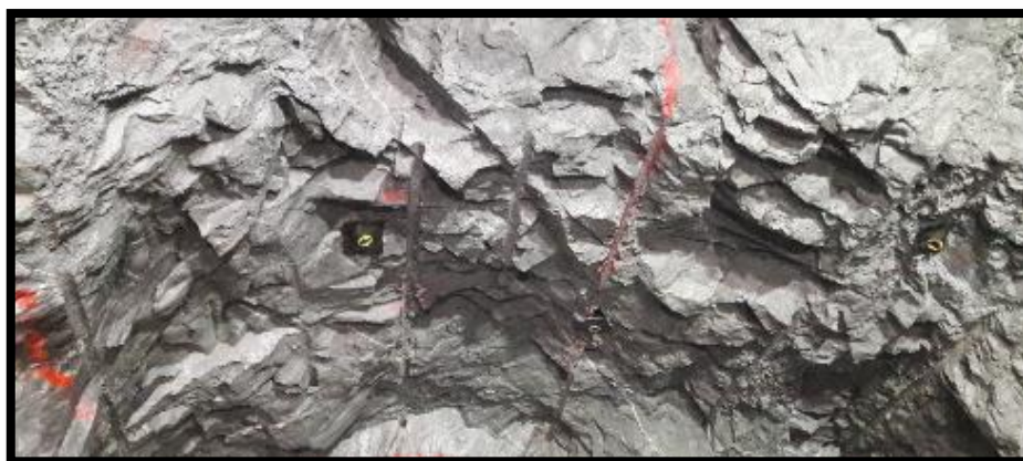
Foto 9: Resultado Post-Voladura presencia de cañas
