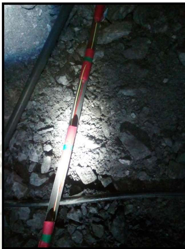
Foto 3: Pentacord atravesando Emulsión
