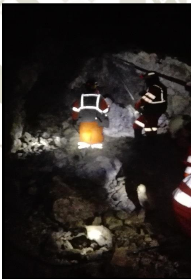
Foto 8: Verificación post- voladura
