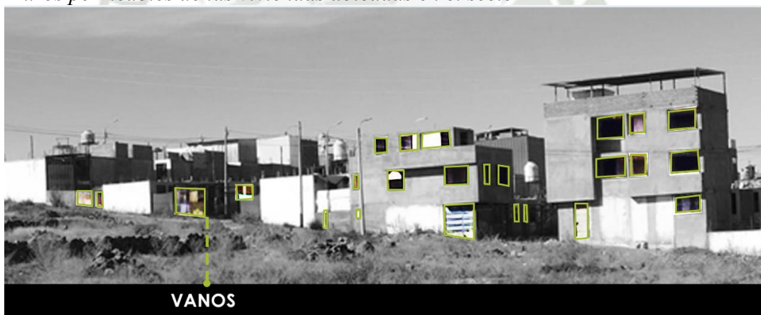
Figura 98 Muros permeables de las viviendas ubicadas en el sector "A"
