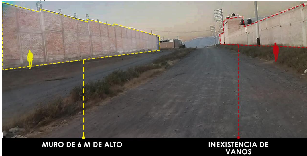
Figura 97 Muros ciegos en el sector "A"
