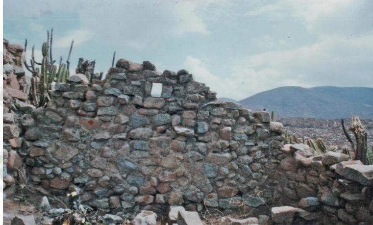
Muro de las viviendas elaboradas de piedra
