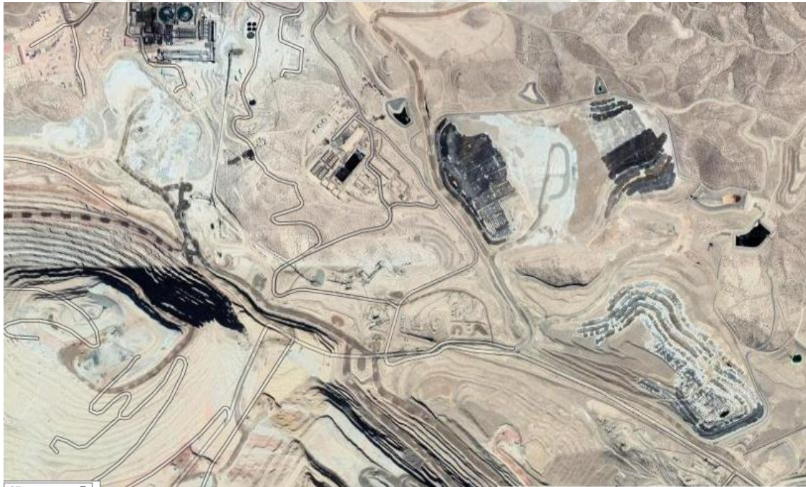
Figura 17. Mina donde se realiza la descarga
