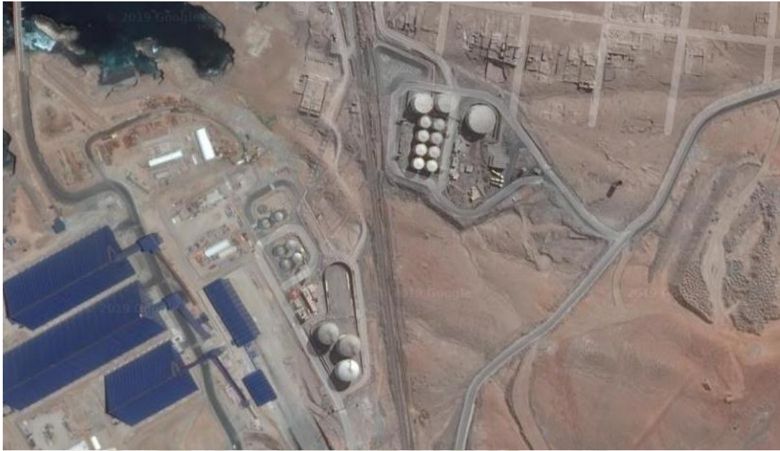
Figura 16. Zona de despacho de material
