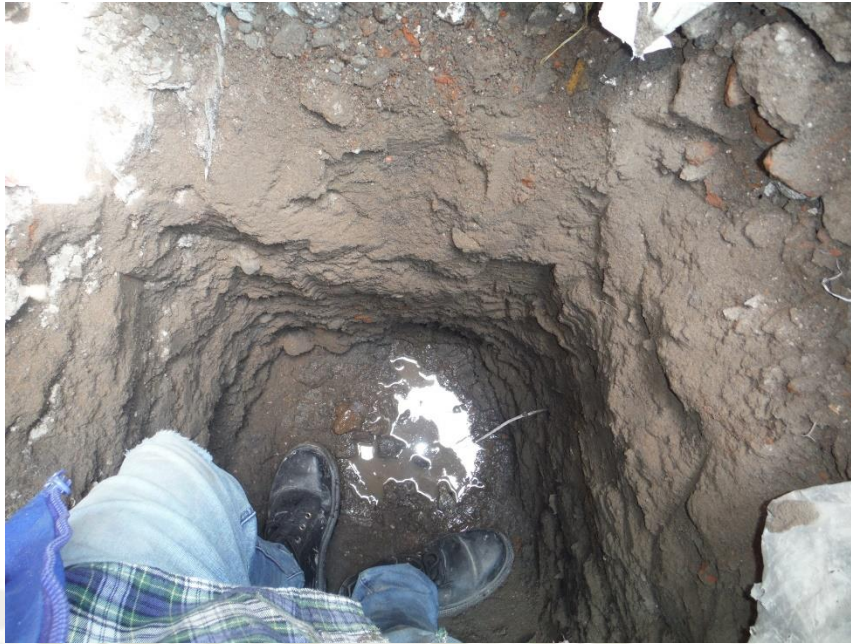
Foto N°03 Vista del nivel freático en el pozo de investigación
