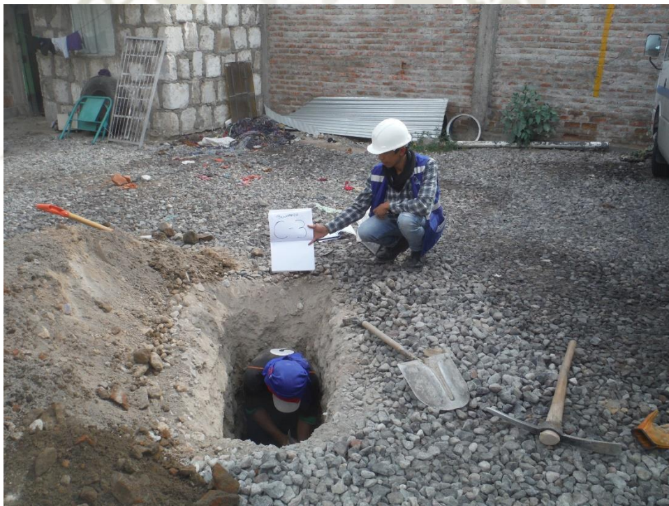
Foto N°02 Vista de la Calicata C-3 durante su excavación
