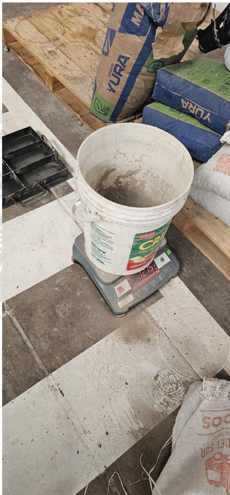
Fotografía No. 16. Pesado de cemento Portland tipo I para mezcla de concreto reciclado
