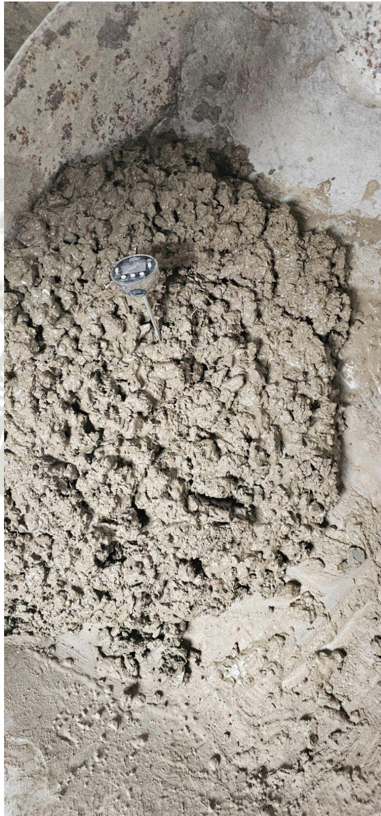
Fotografía No. 8. Verificación de temperatura en mezcla de concreto en estado plástico 1
