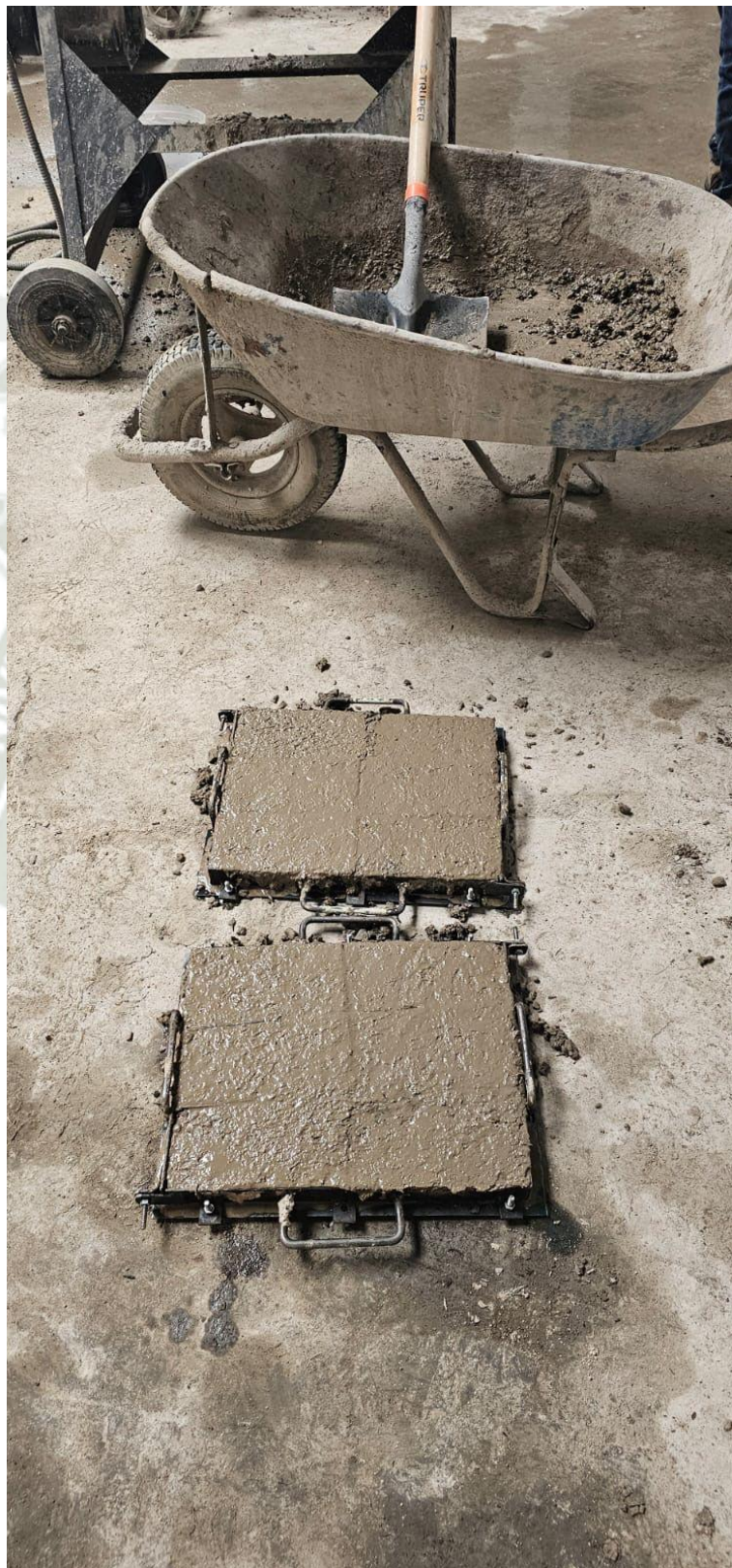
Fotografía No. 12. Vaciado de mezcla de concreto reciclado en moldes para adoquines peatonales
