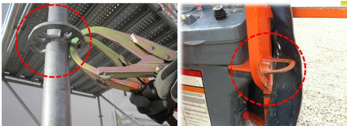
Imagen 19: Forma correcta de anclar la línea de vida en andamios
