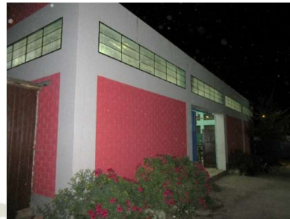
Ilustración 81: Hangar desde vista posterior
