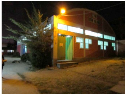
Ilustración 80: Hangar desde el frente
