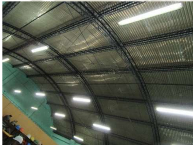
Ilustración 82: Cubierta ligera del hangar
