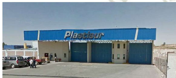
Ilustración 108: Fachada fabrica Plastisur
