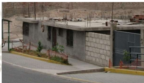
Ilustración 100: Vivienda sin acabados.
