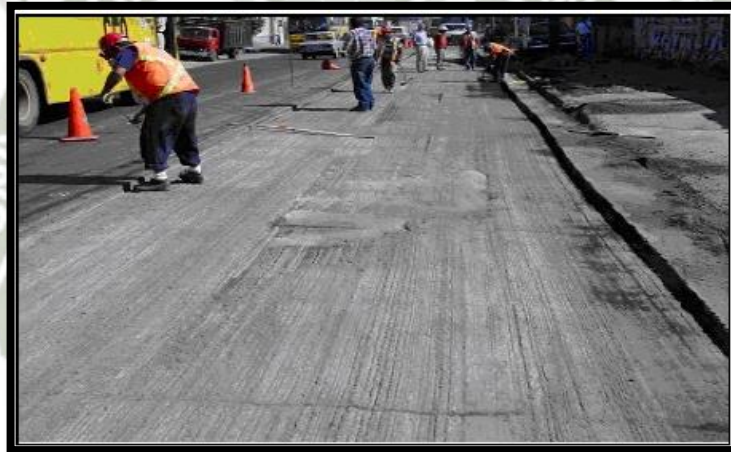
Ilustración 12 Superficie fresada con textura rugosa para obtener una buena adherencia, tomada de "Aplicación en Chile de pavimentos delgados de hormigón", p. 22, de Ruiz J. (2006), Universidad de Chile, Santiago de Chile
