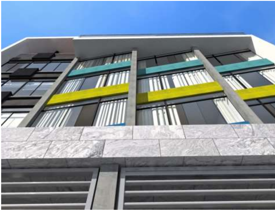
Gráfico N° 35. "Edificio Barreros". Fuente: Elaboración propia.
