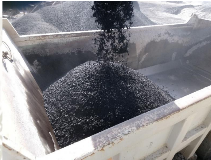
Figura 48: Cargado de mezcla asfáltica en volquete, Fuente: Planta GyA contratistas (2019)
