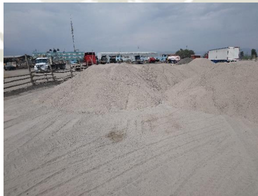
Figura 62: Acopio de agregado fino, Fuente: Planta de asfalto SuperAsfaltos (2019)
