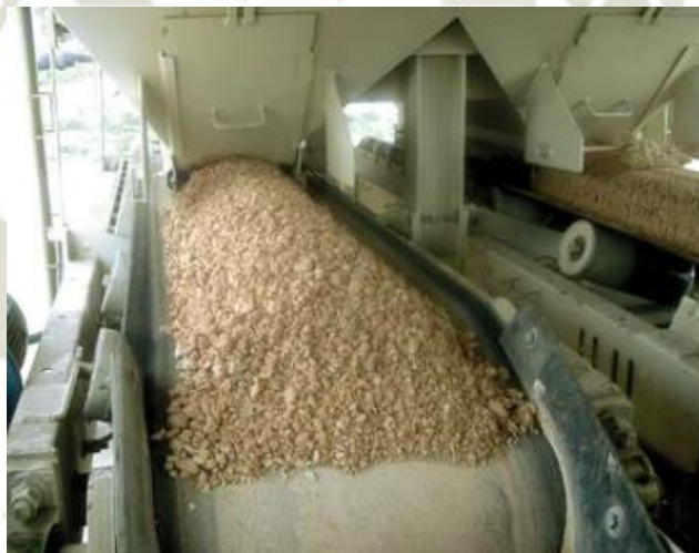
Figura 22: Compuertas de tolvas, Fuente: Manual de plantas TEREX (2018)
