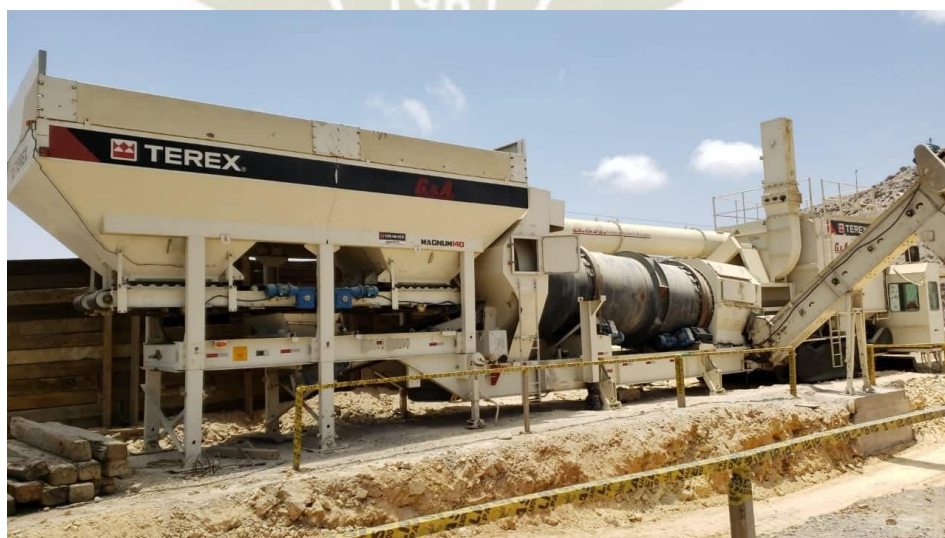
Figura 165 y 166: Planta de asfalto GyA Contratistas, Fuente: Toquepala (2019)
