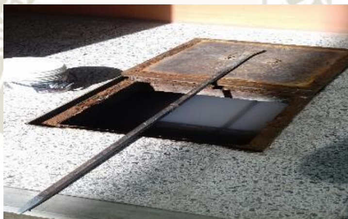
FIGURA N° 4 Pozo séptico ubicado entre el pabellón “H” e “I”
