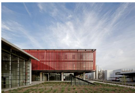
Figura N° 68: Edificio Adm. Lateral
