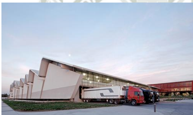
Figura N° 66: Carga y Descarga
