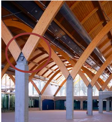
Figura N° 27: Unión de acero entre arcos
