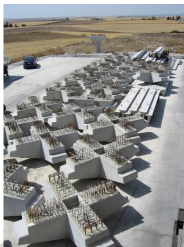
Figura N° 24: Bloques de estructura pre-fabricada
