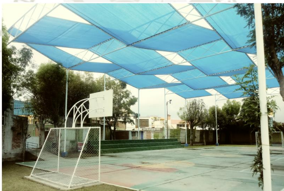
Figura 1. Estructura metálica de cobertura en infraestructura deportiva menor.
