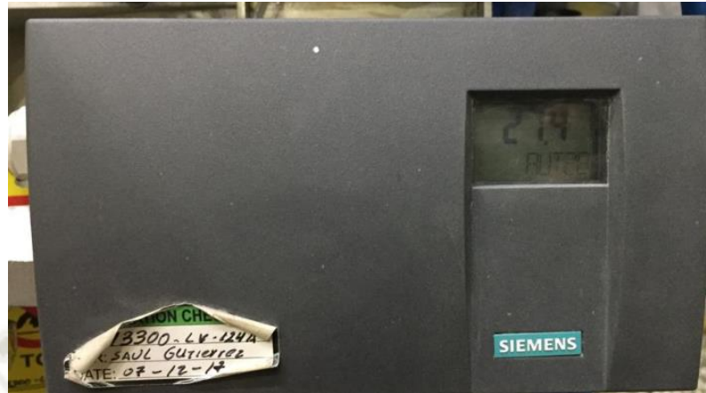
Figura 3.8. Posicionador de válvula modulante LV-001-A.
