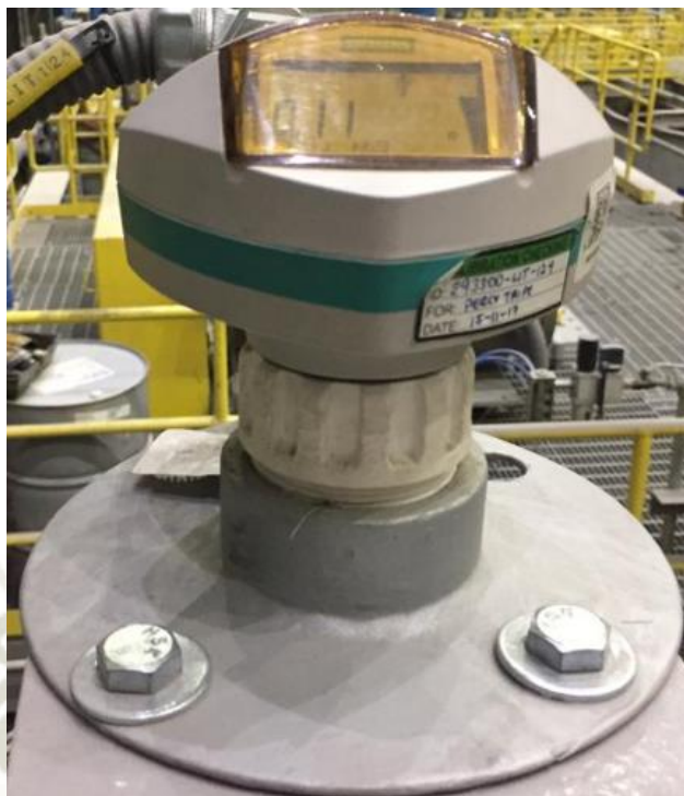
Figura 3.6. Sensor – transmisor de nivel LIT-001.
