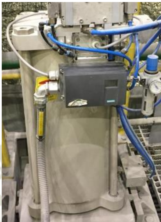
Figura 3.7. Válvula modulante LV-001.
