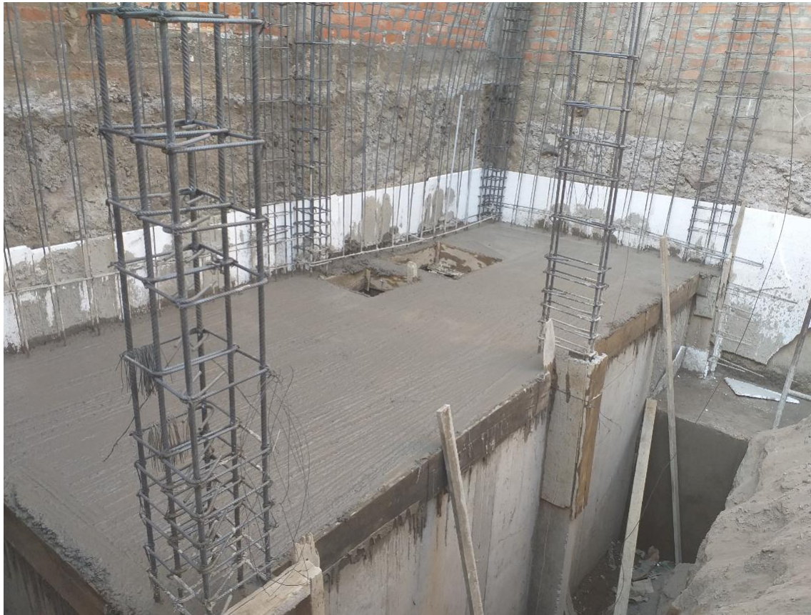
Figura 38. Vaciado de concreto en Losa
