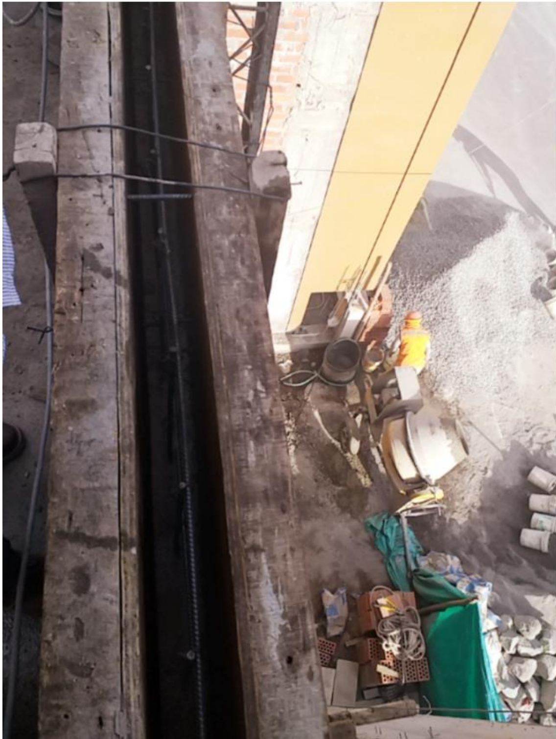
Figura 53. Vista en Picada de Encofrado de Muro
