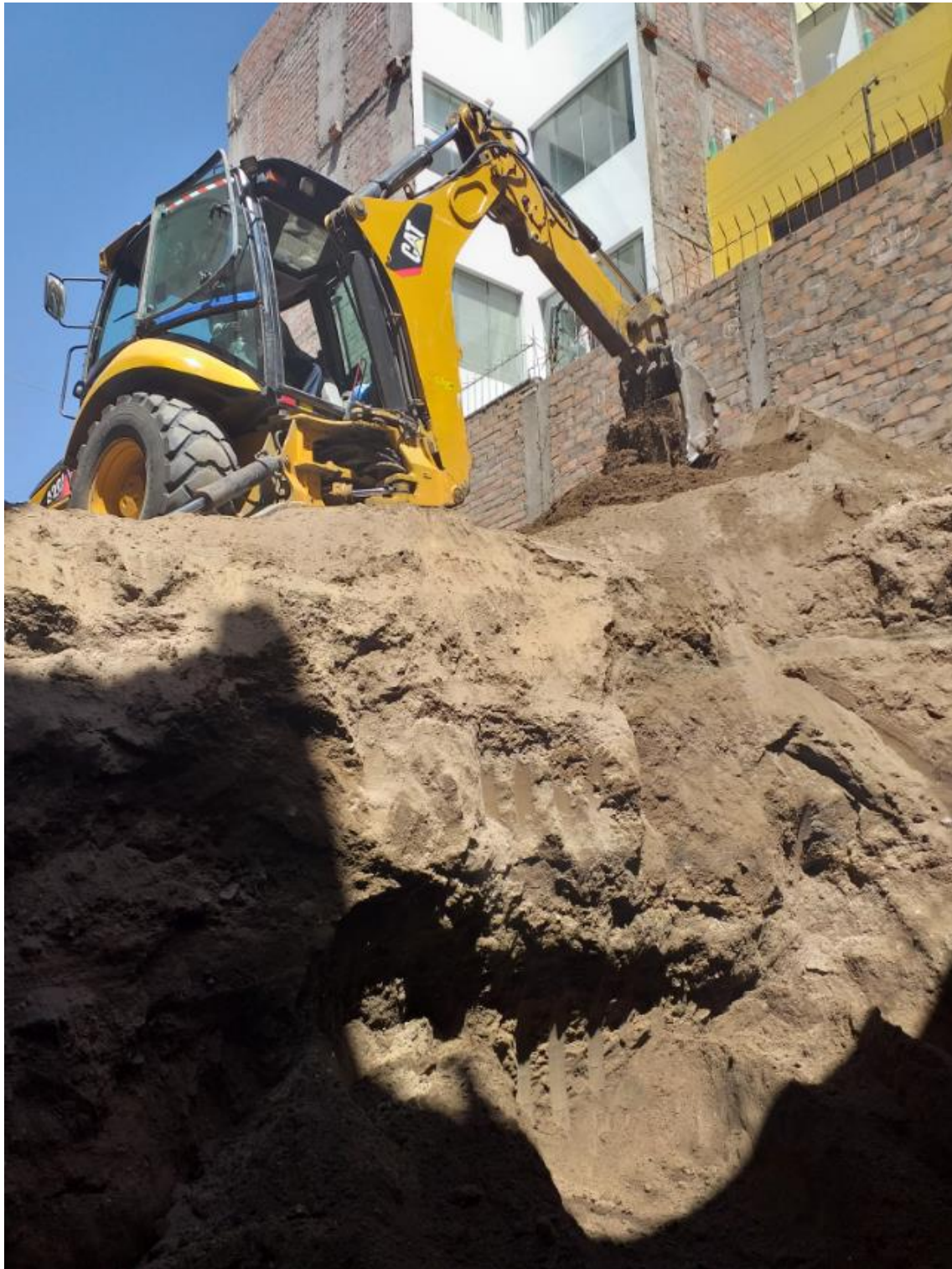
Figura 31. Remoción de Material Excedente con Maquinaria
