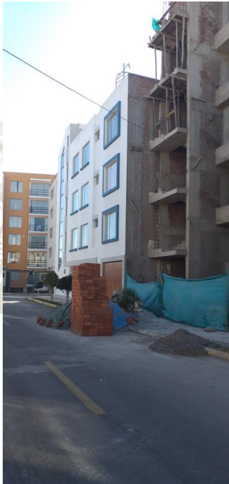
Figura 52. Vista Frontal de la Edificación
