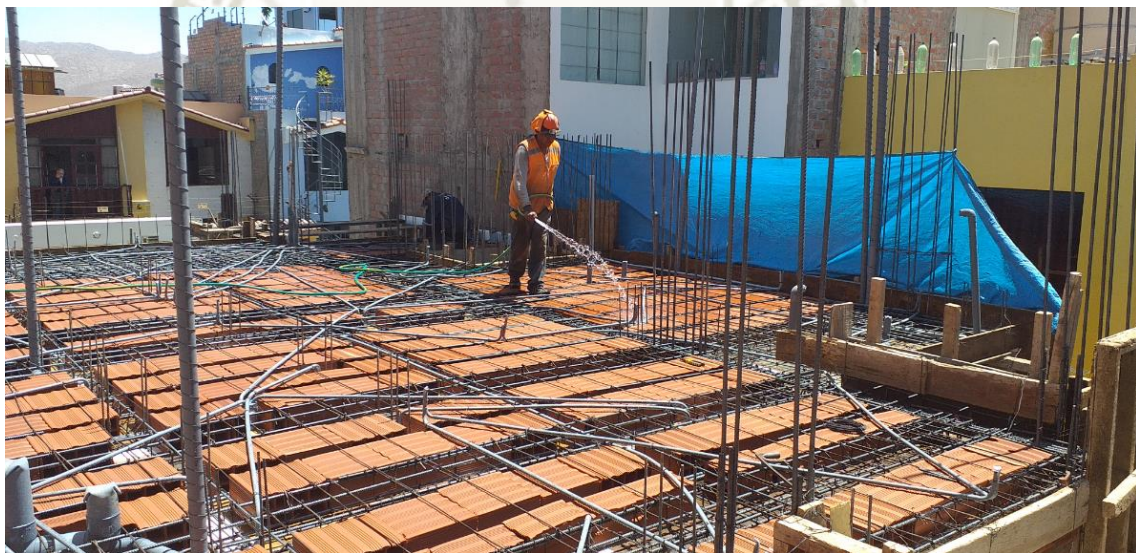
Figura 44. Riego de Unidades de Albañilería
