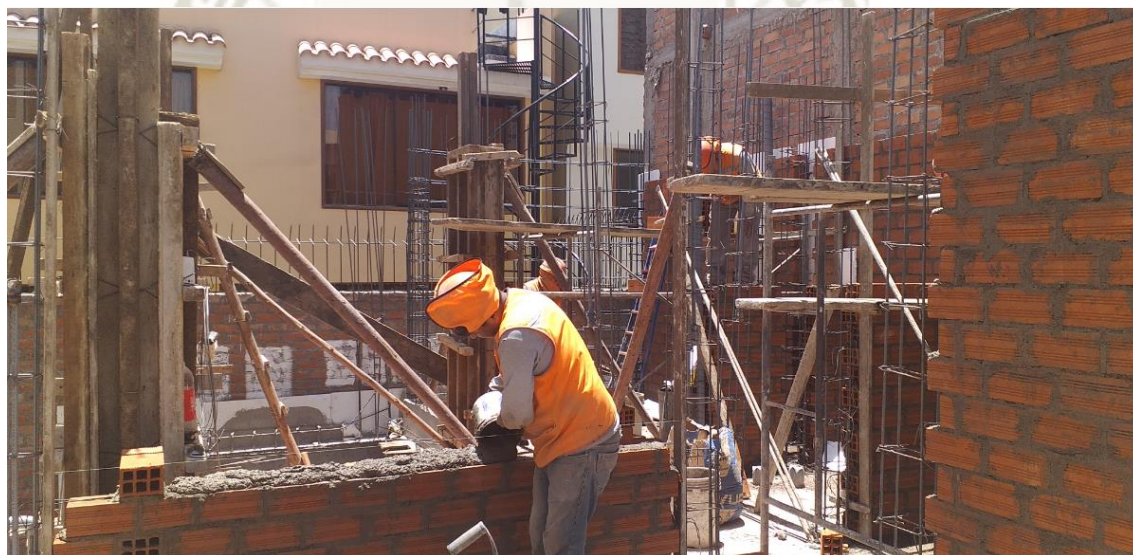
Figura 42. Levantamiento de Muros
