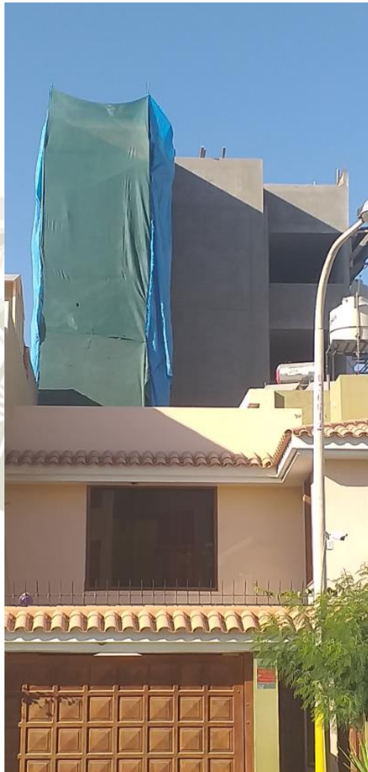
Figura 57. Vista Frontal de la Cubierta
