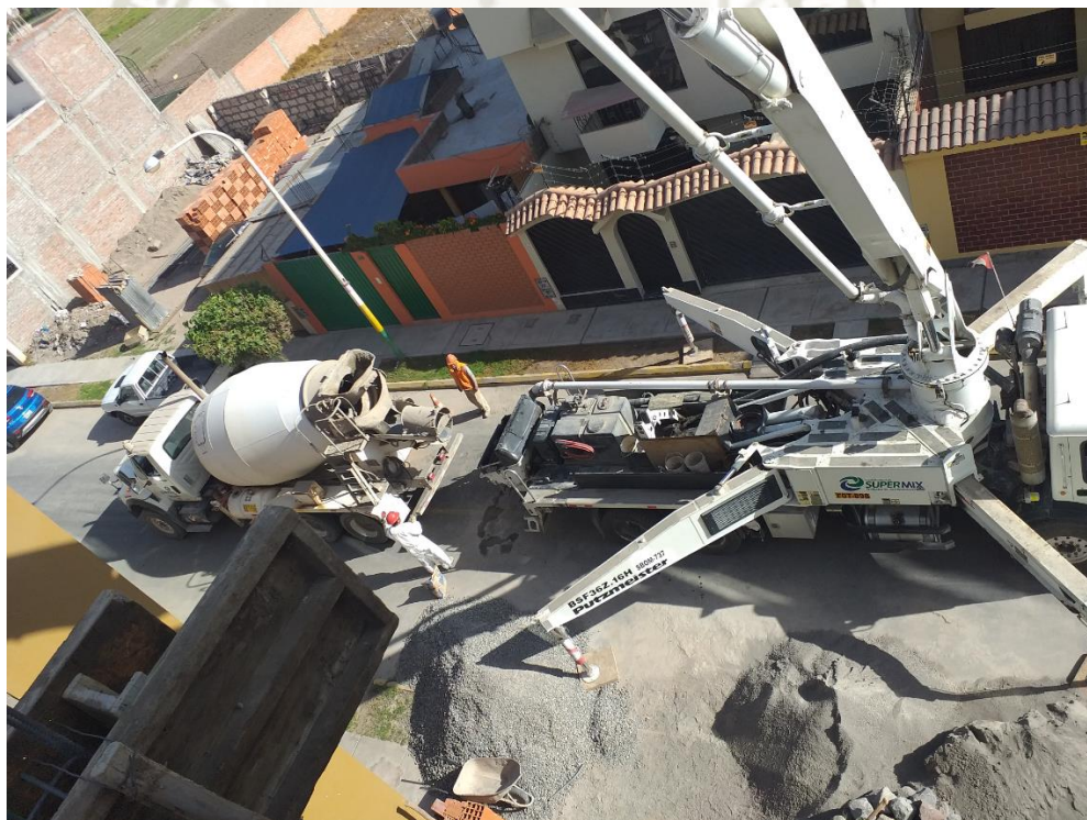
Figura 46. Preparación de Concreto con Mezcladora
