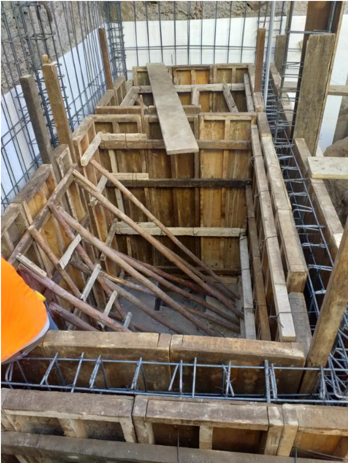
Figura 36. Encofrados para Muros y Columnas
