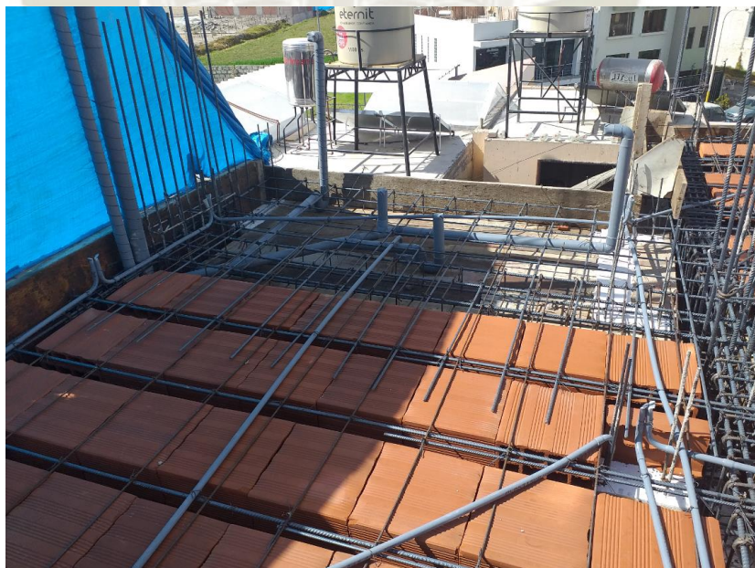
Figura 51. Colocación de Aceros y Tubería en Losa Aligerada
