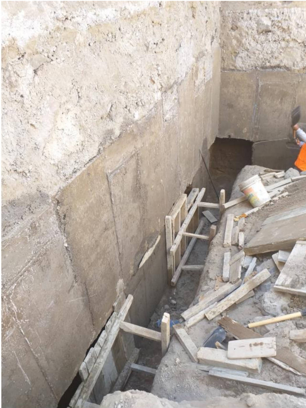
Figura 29. Calzaduras para terrenos aledaños
