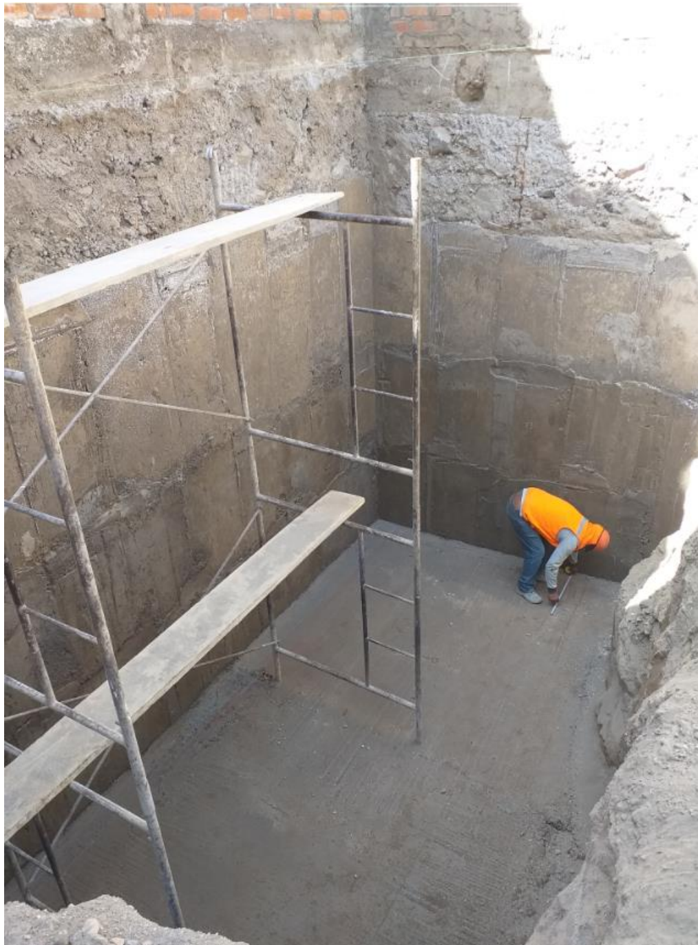
Figura 30. Colocación de Andamios
