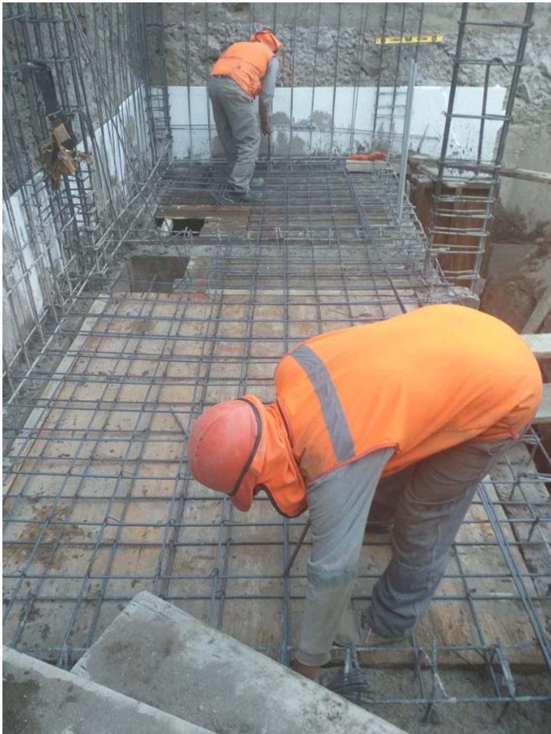
Figura 37. Colocación de Aceros para losa
