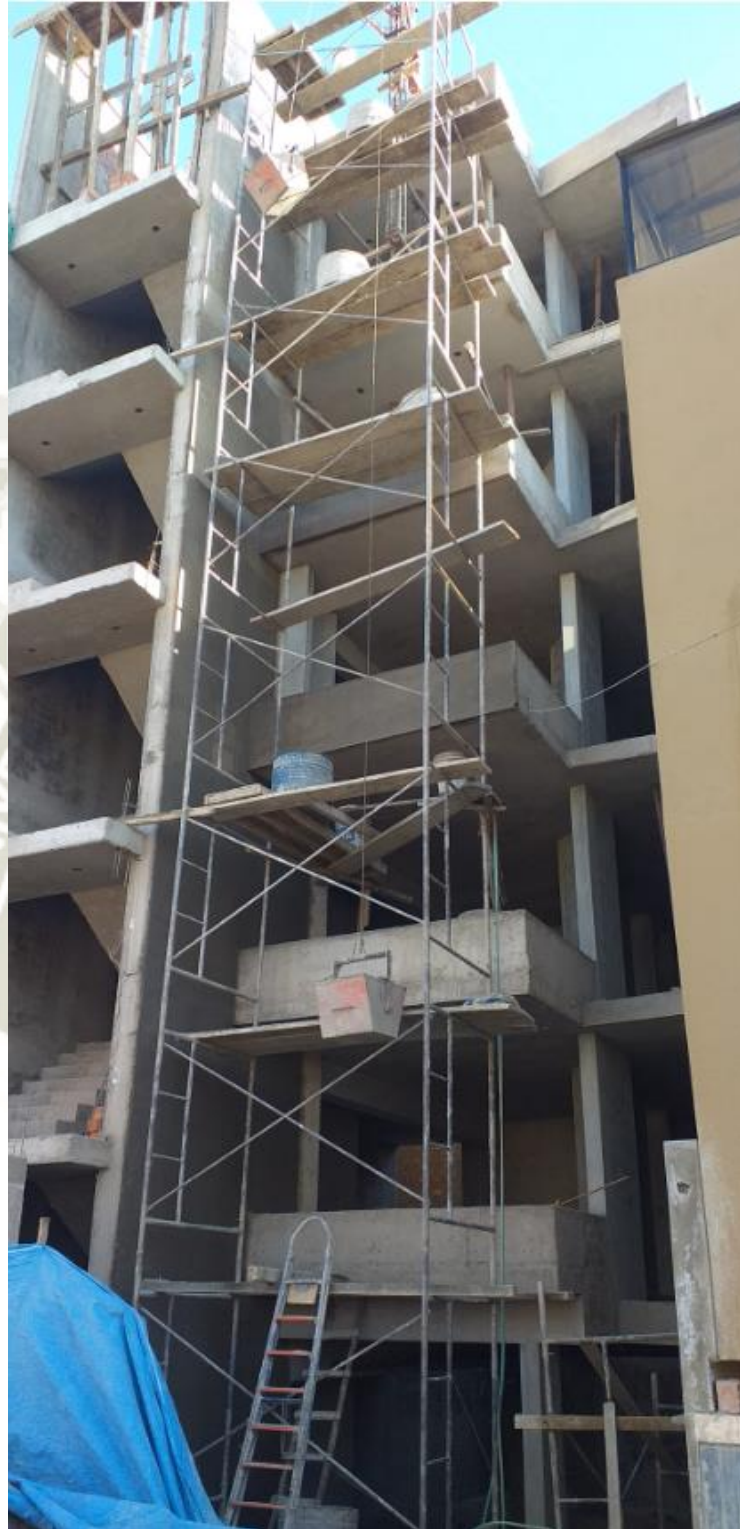
Figura 54. Sistema de Andamios para Todos los Niveles
