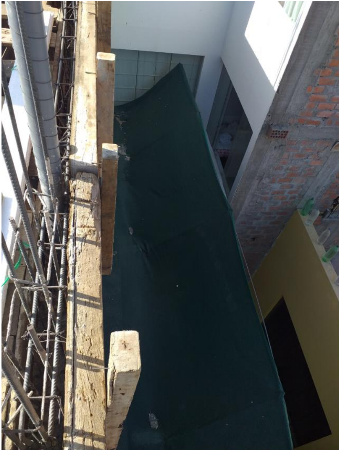
Figura 49. Vista en picada del Encofrado del Muro
