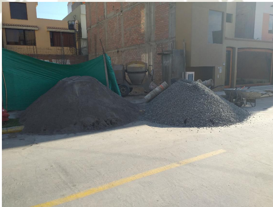
Figura 35. Agregado Fino y Grueso
