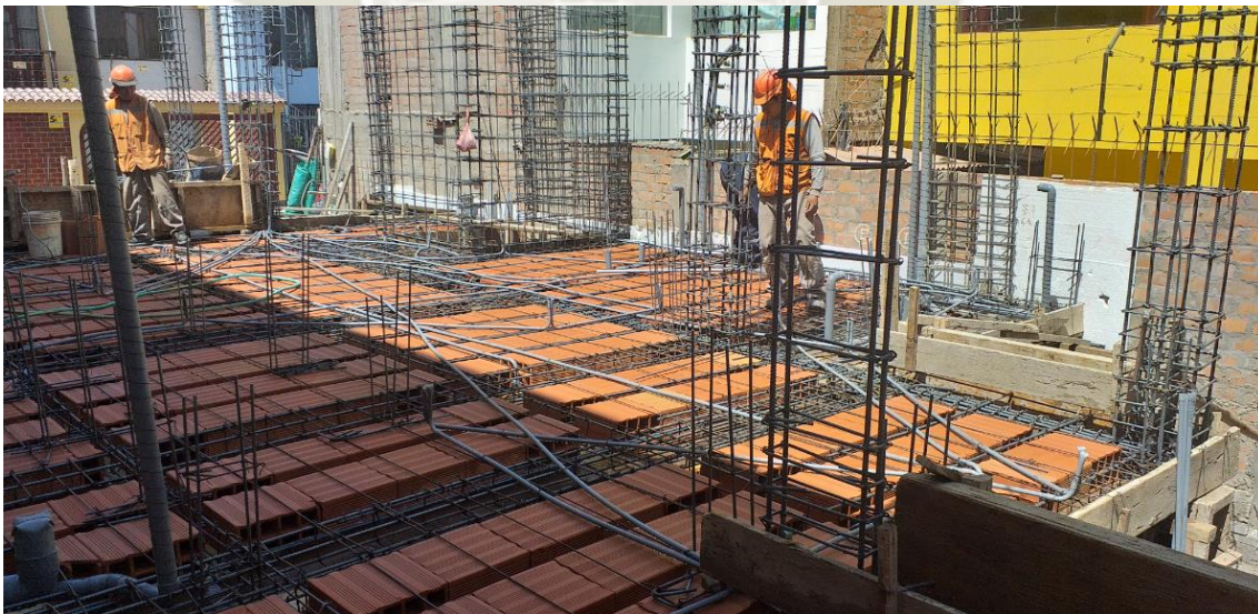
Figura 40. Colocación de Unidades de Albañilería
