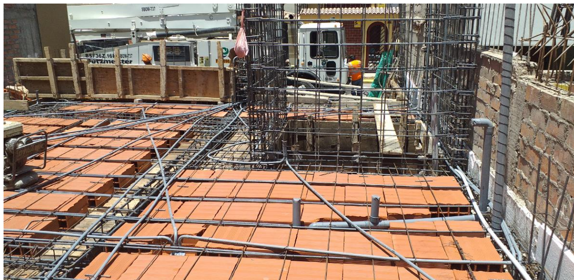
Figura 41. Colocación de Tubería para Luz
