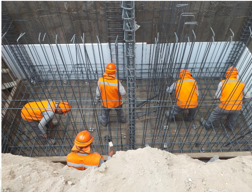
Figura 34. Colocación de Aceros
