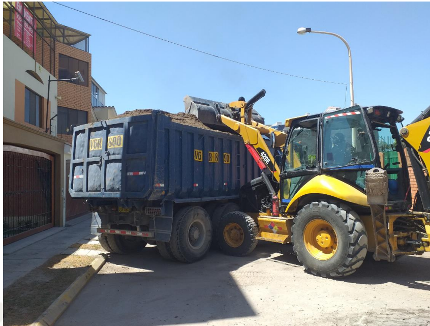
Figura 32. Colocación de material en Volquete con Excavadora
