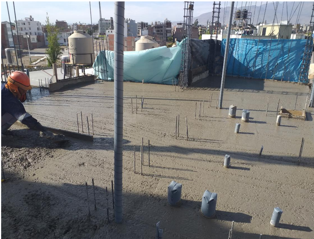
Figura 47. Vaseado de Losa
