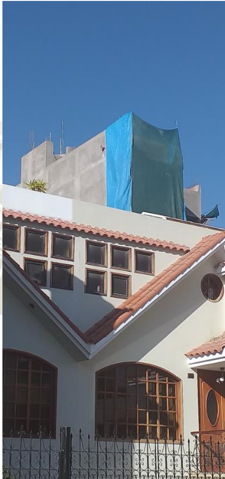
Figura 56. Cubierta de la Fachada
