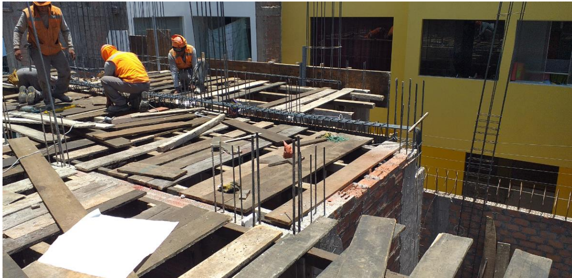
Figura 43. Colocación de Tablones
