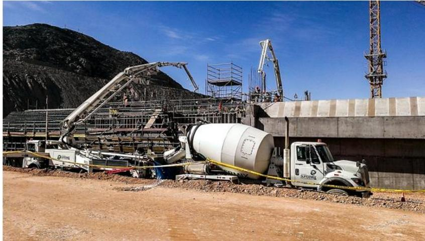
**Fotografía 3: Transporte y Bombeo de concreto a distancia.**
