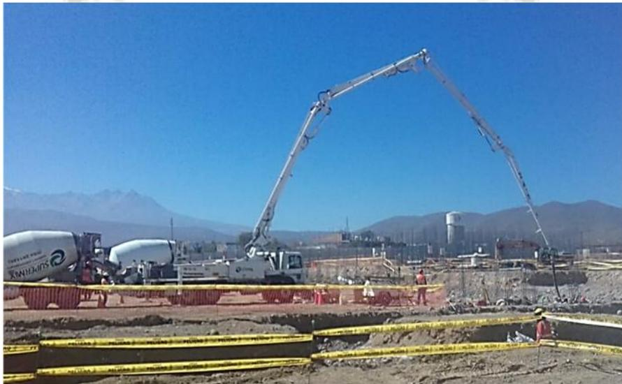
*Fotografía 5: Autobomba Concretera Putzmeister en Proceso de Vaciado.*
