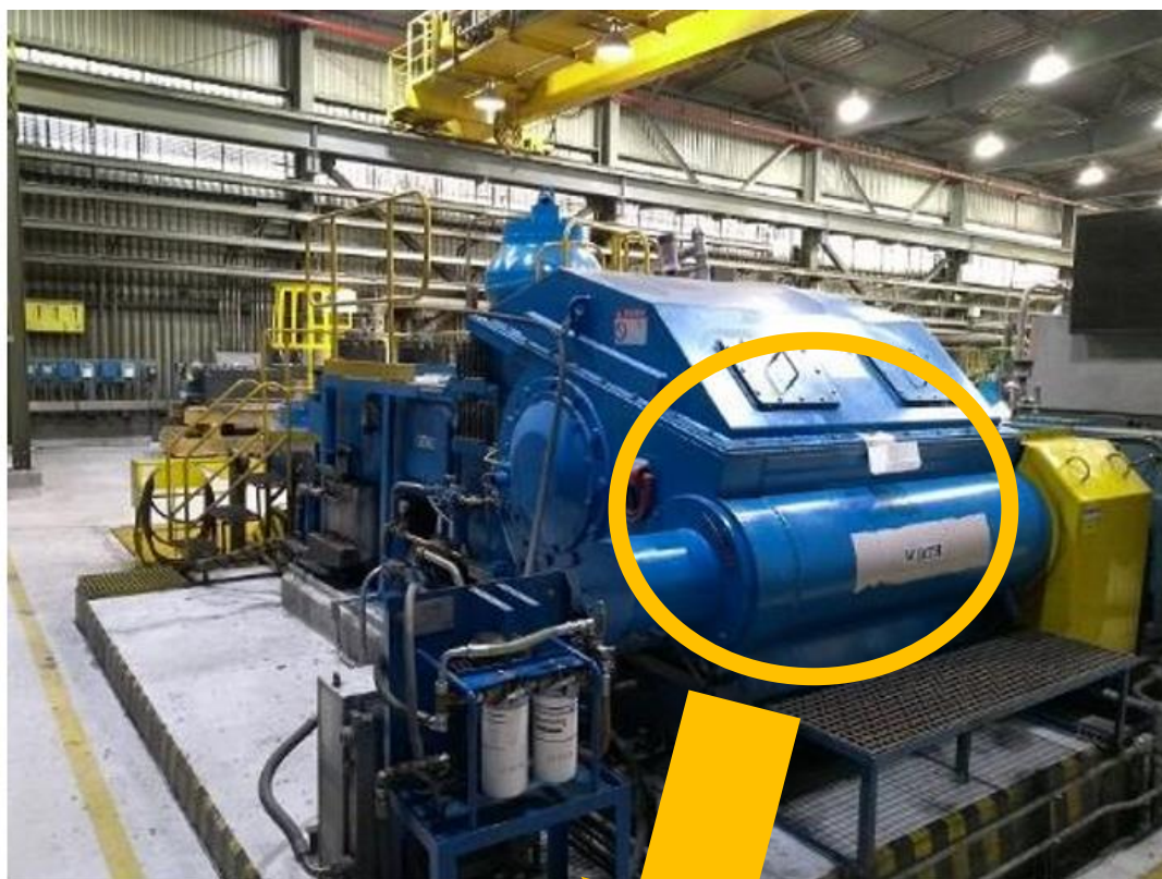
Foto 8. Falla de Pin de cruceta
