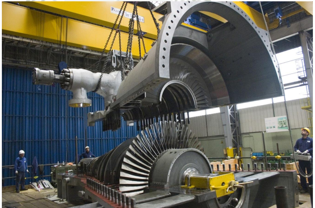
Gráfico 3.72 – Desmontaje de Turbina a vapor
