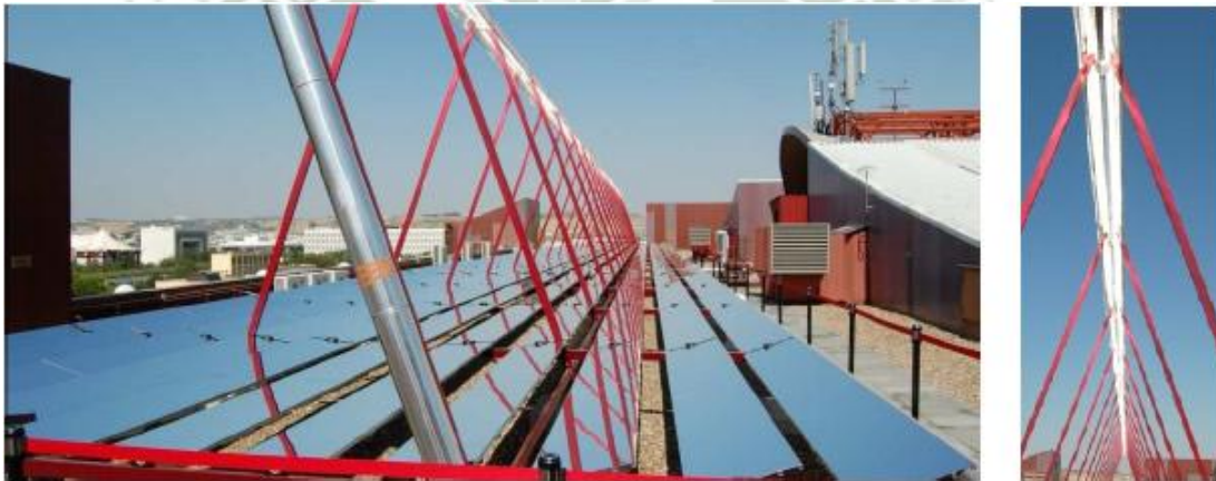
Gráfico 2.6 – Central Solar con concentradores LFR
