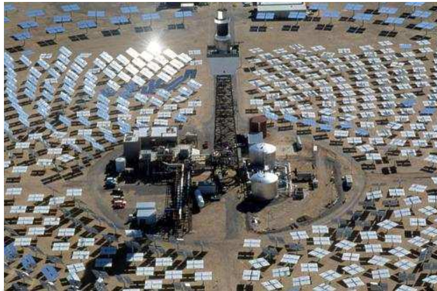
Gráfico 3.3 – Esquema de una central de colector central
