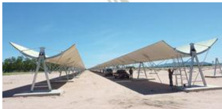
Gráfico 2.9 – Central de Canales Parabólicos
