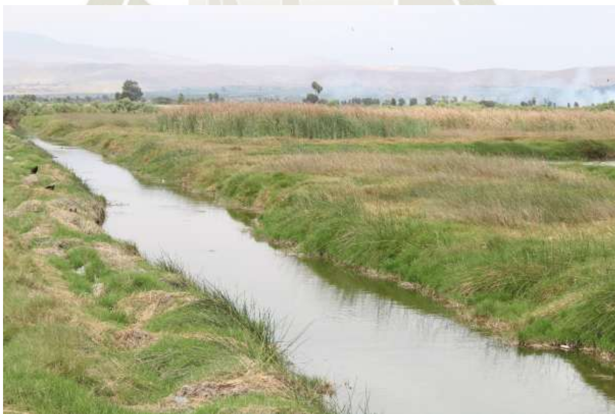
Imagen N°59: Dren; Fuente: Fotografía Propia
