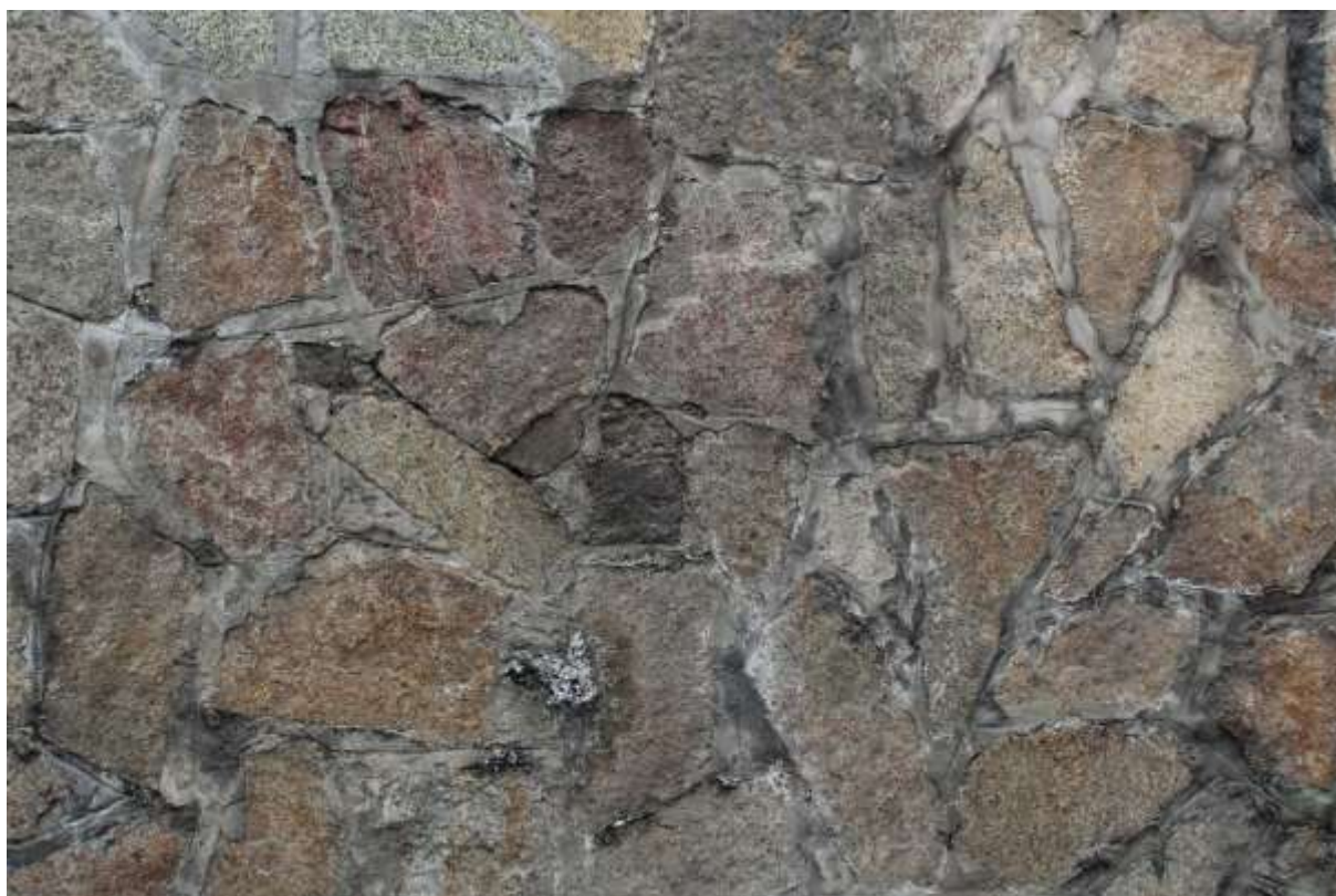
Imagen N°60: Utilización de piedra del lugar; Fuente: Fotografía Propia
