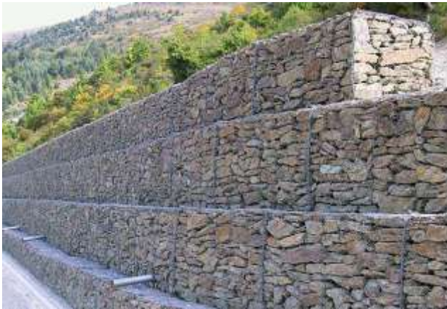
Imagen N°85: tecnología constructiva de gaviones de piedra.; Fuente: www.google.com/imágenes
