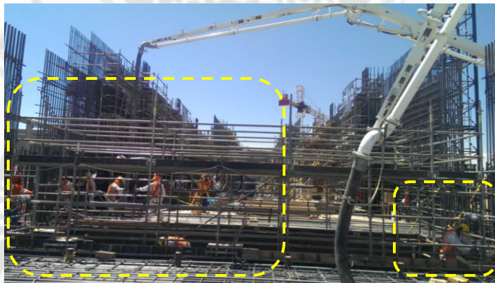
Figura 90, Personal en espera a falta de mixers
