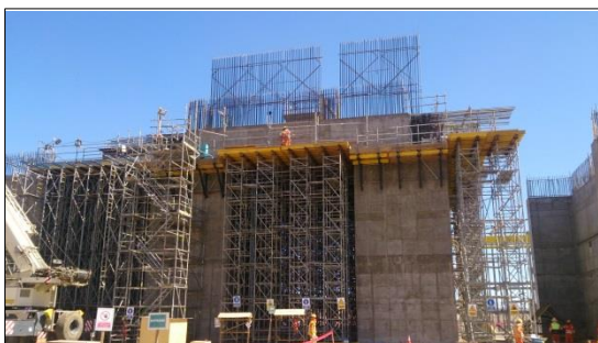
Figura 73, Vista oeste de los muros de alimentadores con losas N1@N2 y N2@N3 vaciadas.
