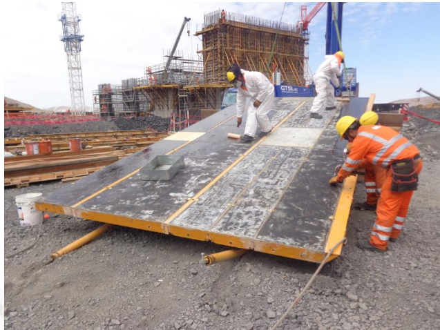
Figura 46, Colocacion de desmoldante a los paneles de encofrado
