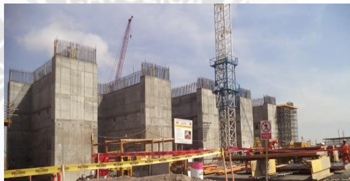
Figura Nro. 24 Muros en avance al 10/03/14 empezando la colocación de acero de la losa N1 N2
