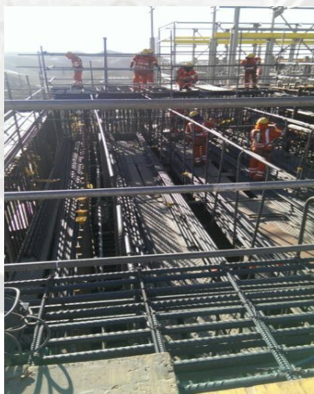
Figura 68, Colocación de acero en losa elevada
