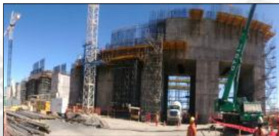
Figura 74, Alimentadores de molinos con muros a cuarto nivel en acero entre ejes N1@N2
