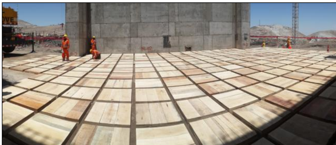
Figura 53, Distribución de durmientes de madera, e=0.10\text{m}
