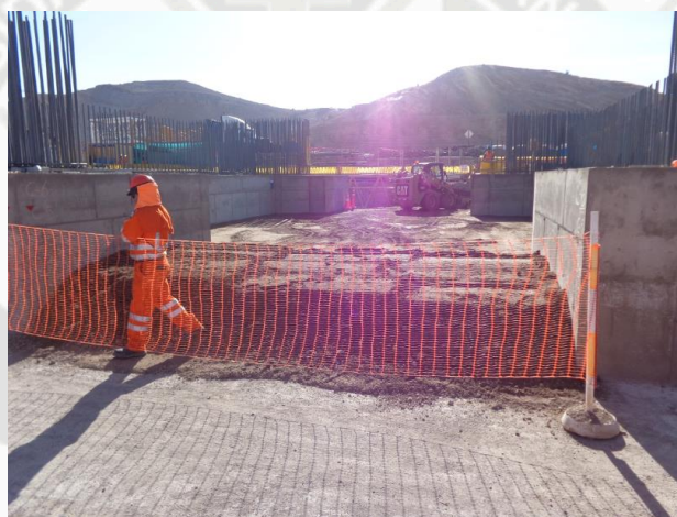
Figura 54, Relleno y compactación entre los ejes F2N6 y F2N7
