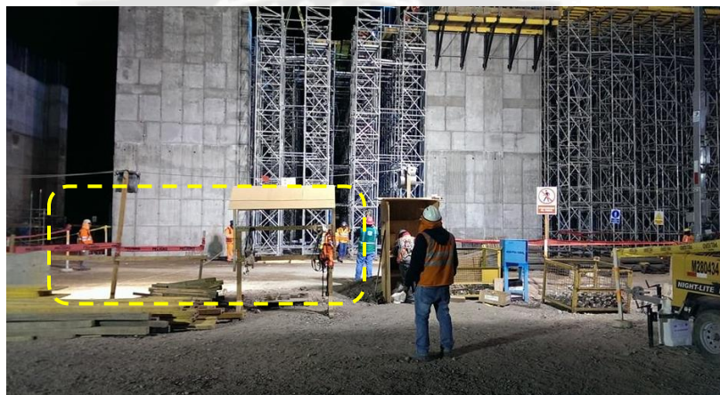
Figura 93, Colocación de alzaprimado N2 N3, personal en espera.
