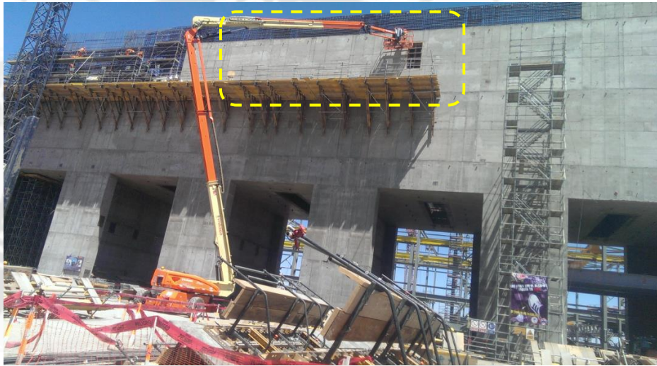
Figura 98, Trepas tienen la misma dimensión, así que solo se retira y se coloca en la parte superior
