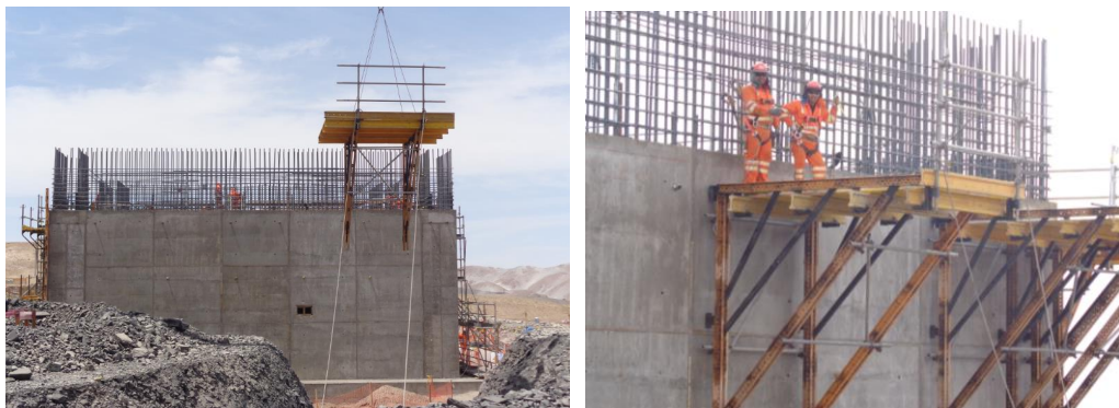
Figura 34, Colocación de consolas de trepas en los muros
