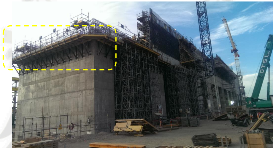
Figura 65, Trepas para la losa elevada losa elevada N13
