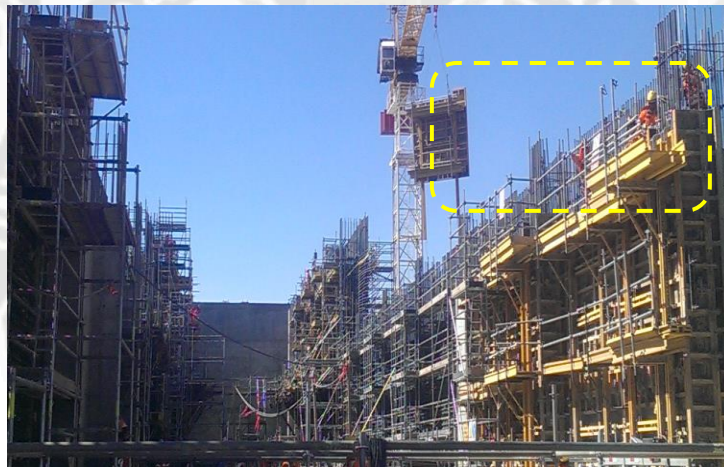
Figura 83, Desencofrado de muro 3ra altura, personal en espera a causa del izaje
