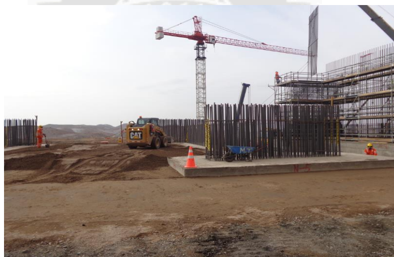
Figura 55, Relleno y compactación entre los ejes N4 al N6
