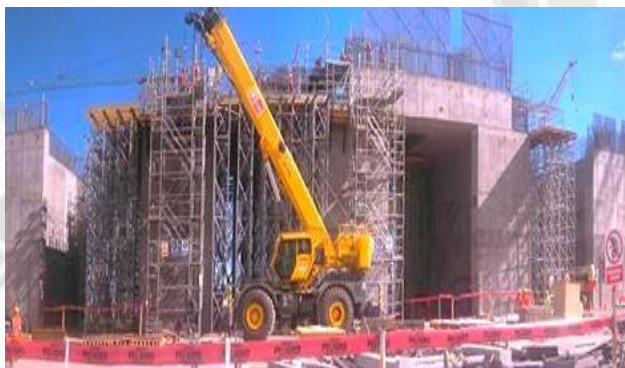
Figura 28 Apoyo de grúas móviles hidráulicas, muro N7 N8 (08/05/14)
