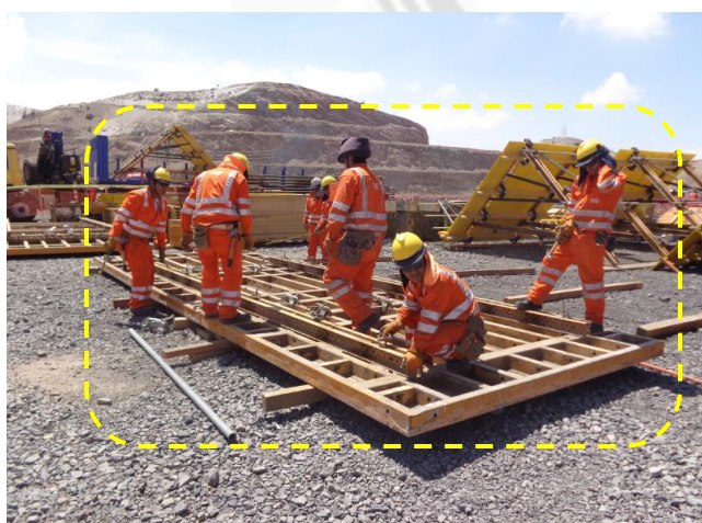
Figura 87, Pre-armado del panel (cuadrilla sobre-dimensionada)
