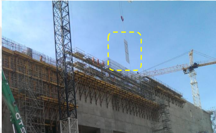
Figura 95, Izaje de peineta para muro de la 4ta altura
