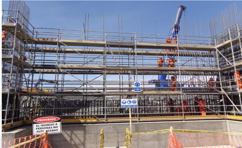
Figura 42, Colocacion de acero muro N1 1ra altura
