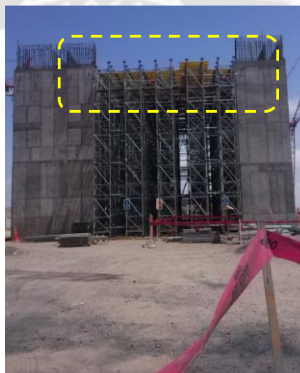
Figura 64, Castillo con mesas para fondo de losas
