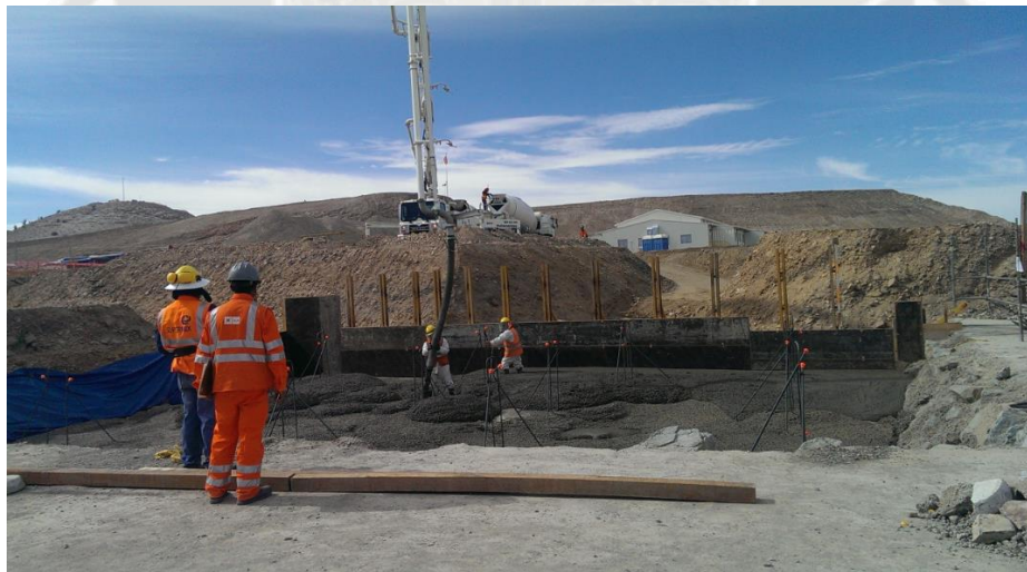
Figura 40, Vaciado de Lean concrete en las fundaciones N12 y N13 al nivel 2800
