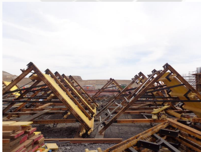
Figura 49, Trepas pre-armadas listas para ser ensambladas
