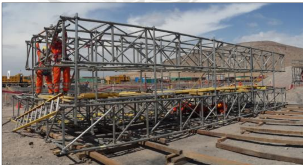
Figura 62, Castillo de 3x3 en forma horizontal
