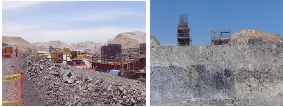
Figura 25 Limitación del área de trabajo izquierda: lado este, derecha: lado oeste
