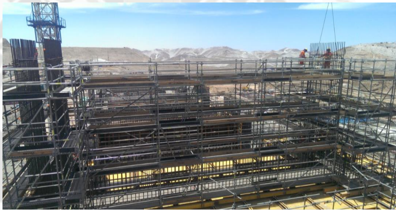
Figura 43, Colocacion de acero a base de peinetas en muro 2da altura
