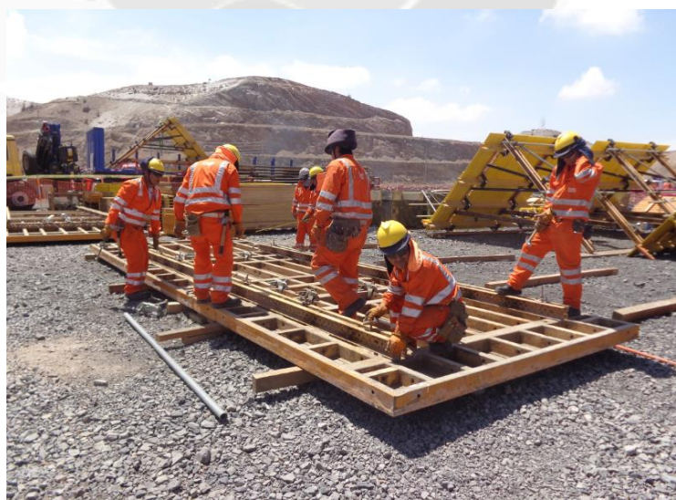
Figura 45, Pre-armado del encofrado y consolas de trepas de los muros
