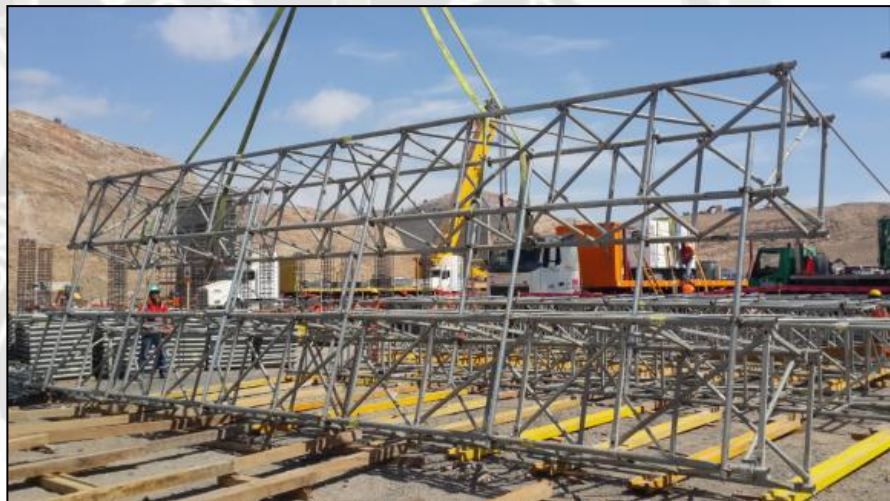
Figura 61, Izaje en campo de castillos 1 x 3 con las eslingas a 60°
