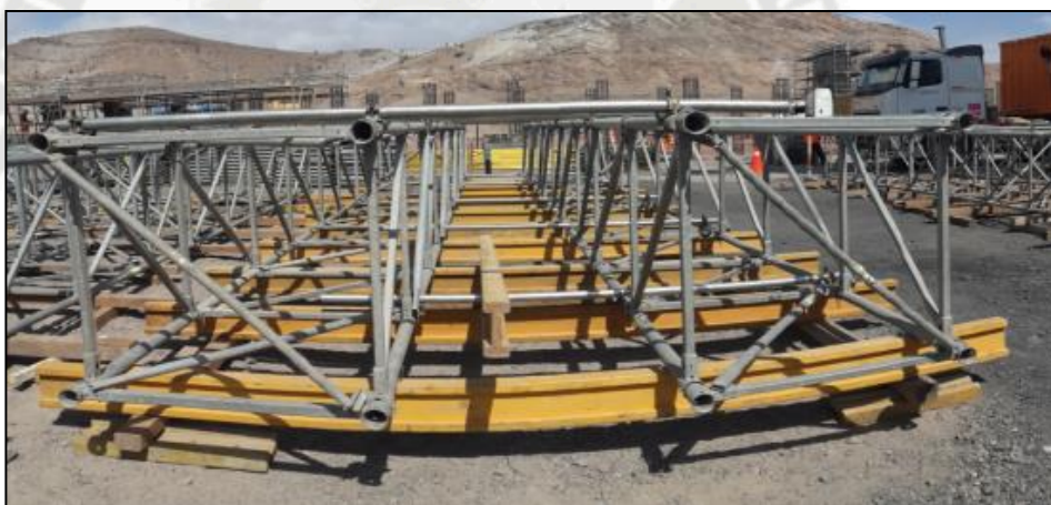
Figura 59, Pre-armado horizontal del castillo del alzaprimado
