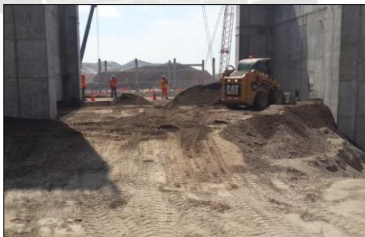
Figura 52, Relleno y compactado del 1er paño de la losa elevada
