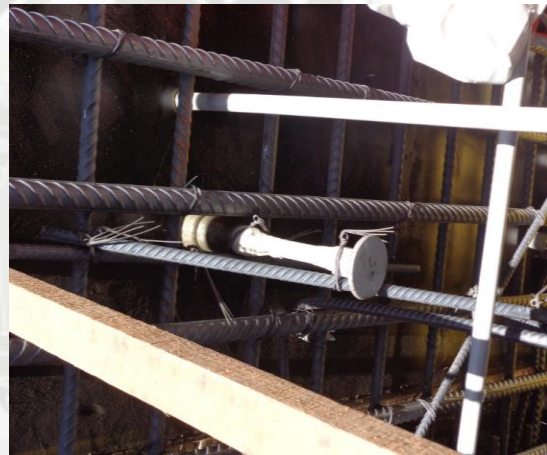
Figura 47, A la izquierda Personal dentro de la estructura pasando esparrago, a la derecha cono para consola de trepa
