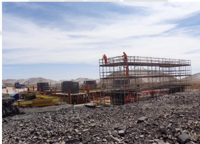
Figura 41, Armado de andamio para muro 1ra altura
