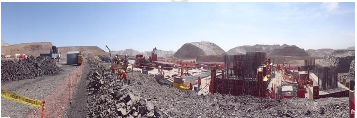
Figura 75, Tren de trabajo para las fundaciones (10/12/13)
