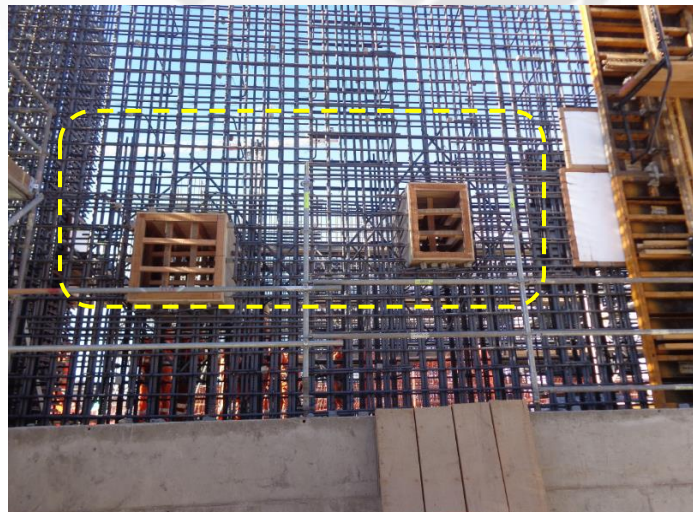
Figura 44, Colocacion de ventanas y embebidos en las estructuras de acero
