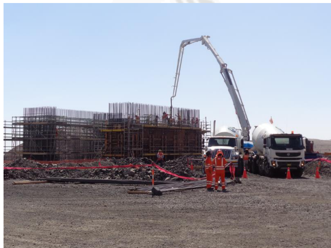
Figura 48, Vaciado de concreto muro 1ra altura
