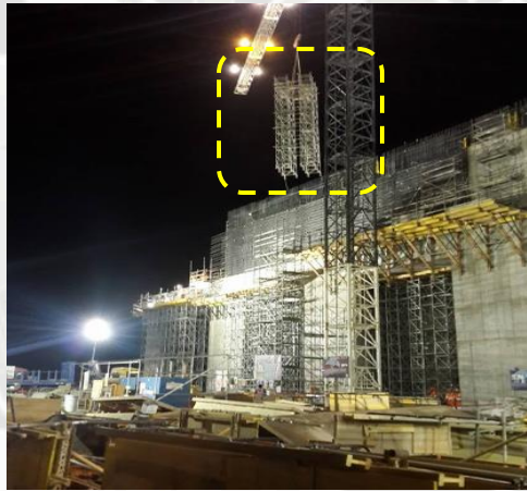
Figura 92, Izaje de alzaprimado
