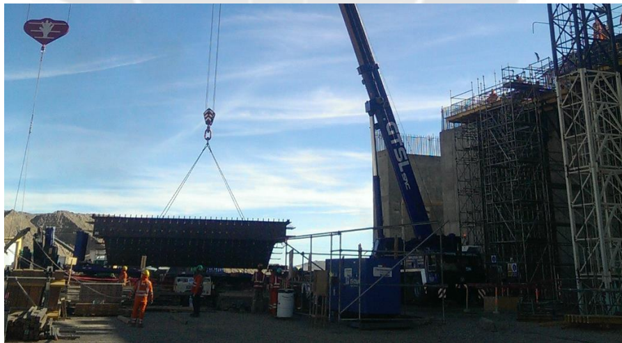
Figura 66, Izaje del inserto de 13 tn losa entre los ejes N12 y N13
