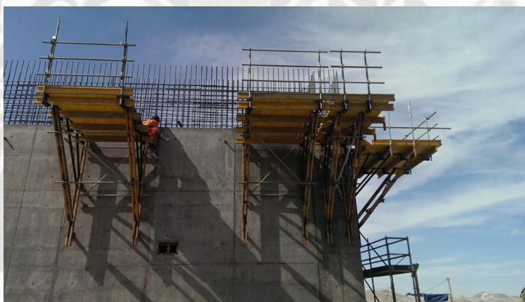
Figura 51, Aseguramiento de las trepas, personal anclado en la línea de vida.
