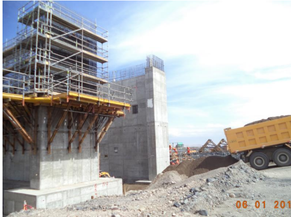
Figura 36, Relleno entre los ejes N1 y N2
