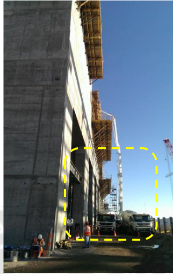
Figura 99, Lado oeste del Alimentador, se realizó plataforma con relleno recuperable.
