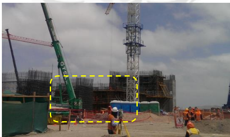
Figura 84, Desencofrado de muro, personal en espera
