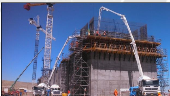
Figura 72, Vaciado de concreto en losa elevada entre los ejes N1@N2 (31/04/14)
