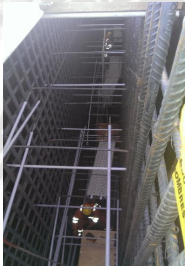
Figura 47, A la izquierda Personal dentro de la estructura pasando esparrago, a la derecha cono para consola de trepa
