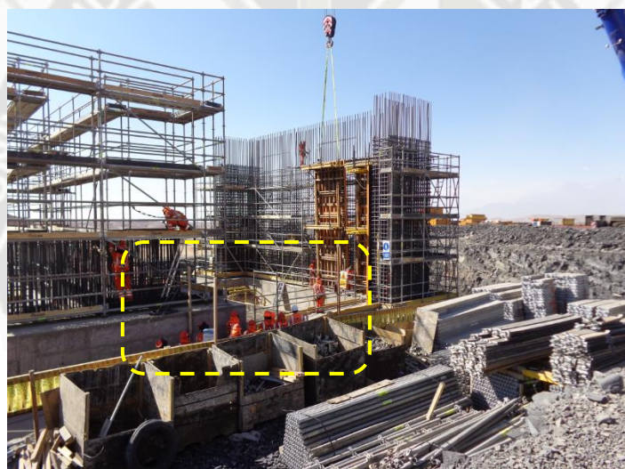
Figura 86, Encofrado de panel (personal en espera a causa del izaje)
