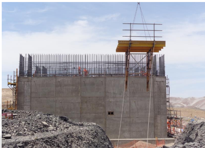
Figura 50, Izaje de la consola de trepa
