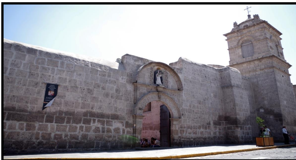
Imagen N°1: Fachada Principal del Monasterio de Santa Catalina
