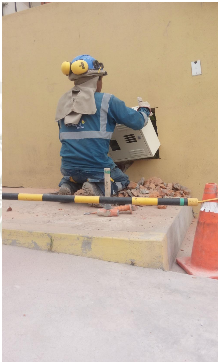
Fotografía 6: Instalación de Gabinete
