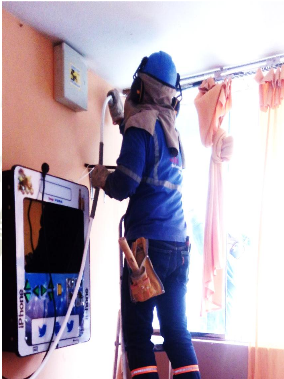
Fotografía 2: Instalación de tubería PE AL PE
