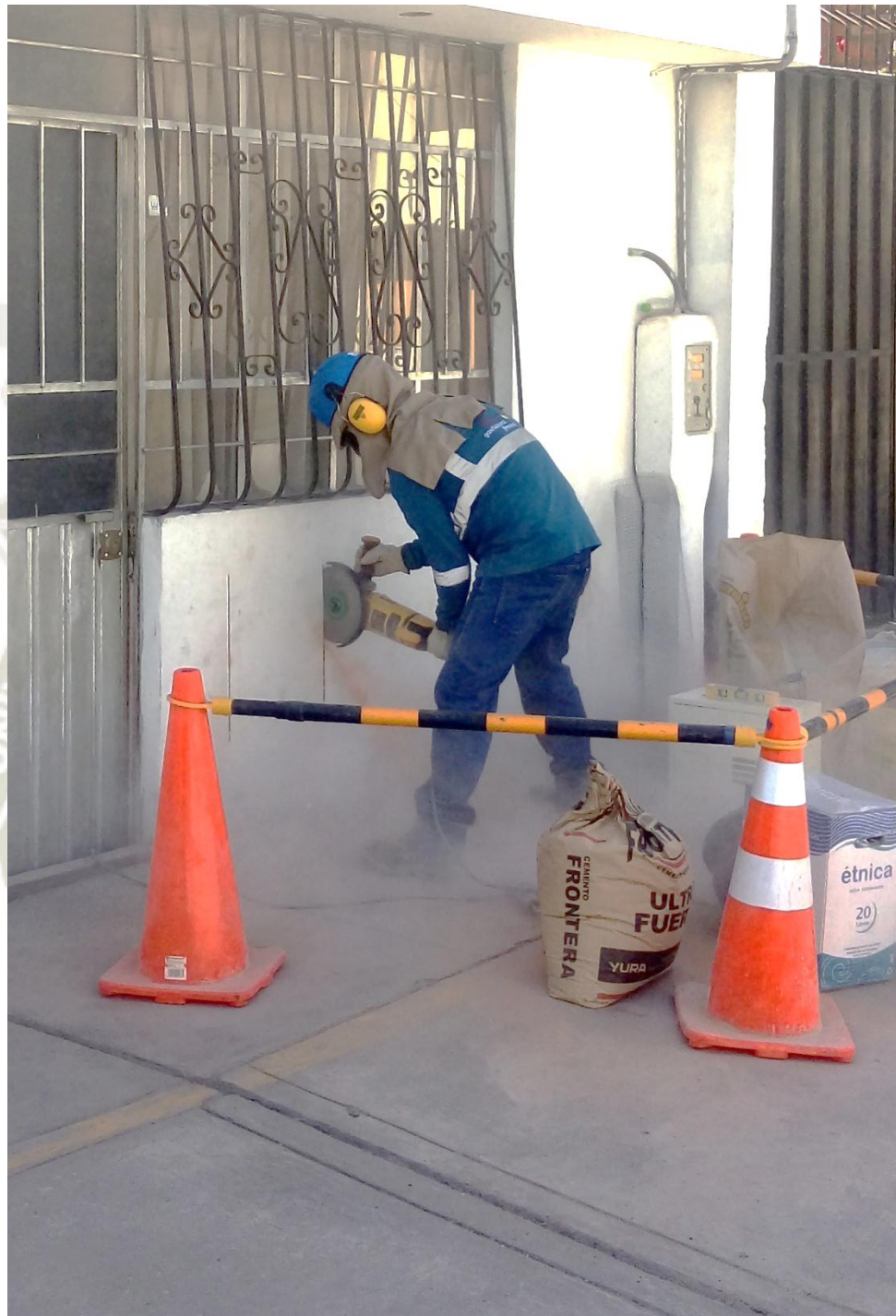
Fotografía 5: Demolición para instalación de gabinete simple
