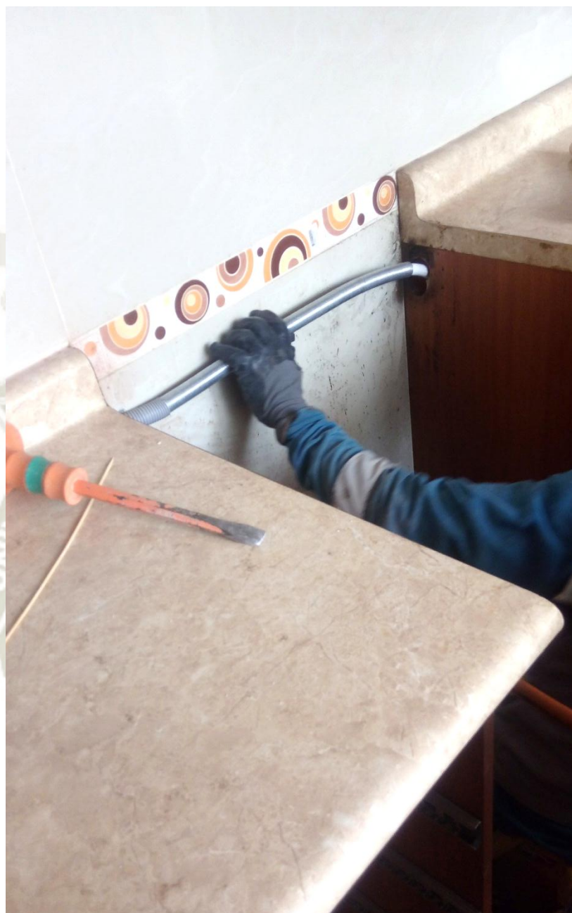
Fotografía 4: Colocación de punto de instalación para gas doméstico
