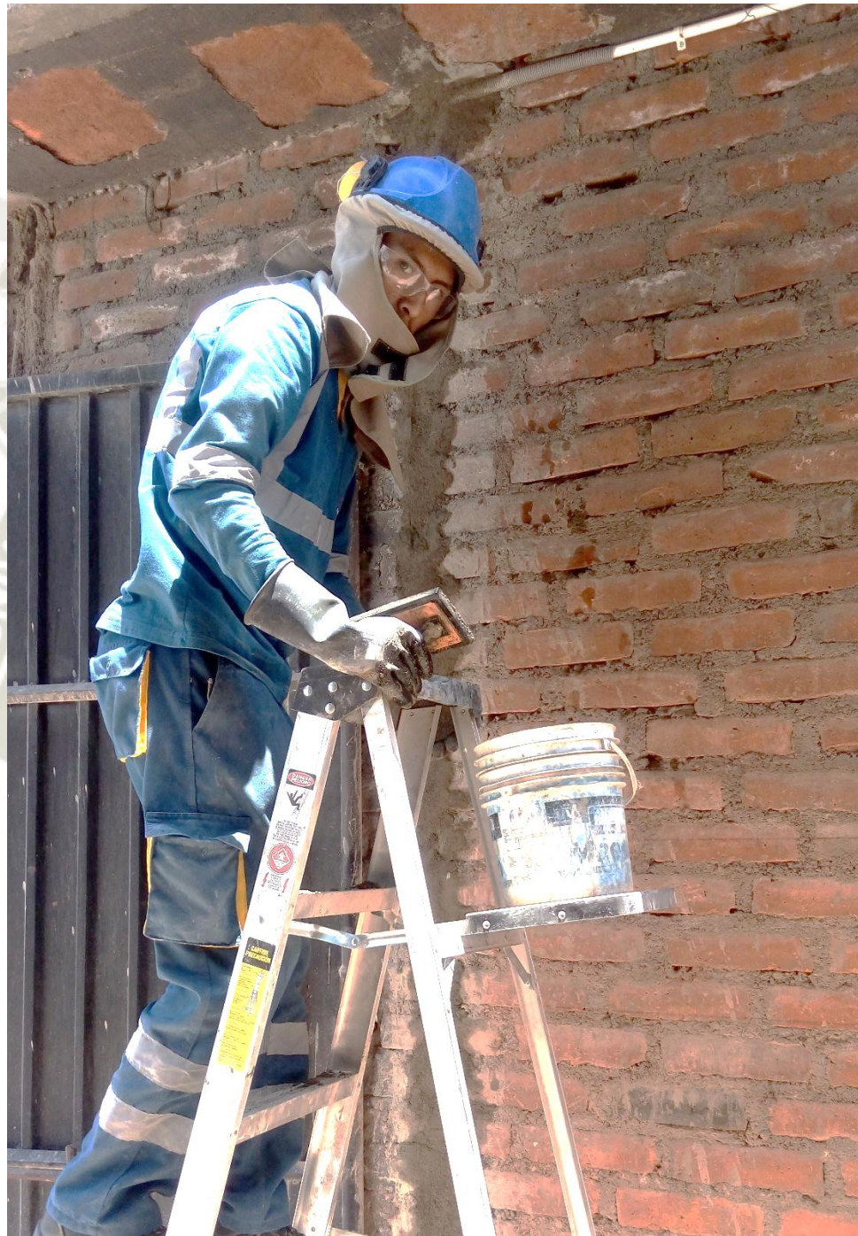
Fotografía 3: Resane de demolición realizada para pasar la tubería PE AL PE continua
