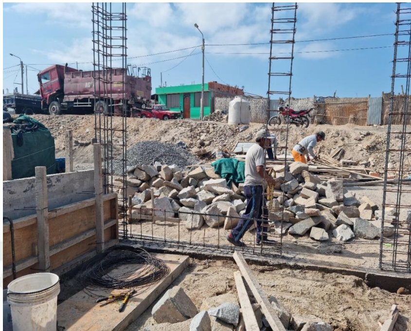
Figura 14 Cimentación con nivel freático alto
