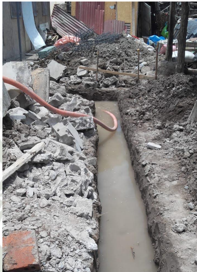
Figura 13 Cimentación con nivel freático alto
