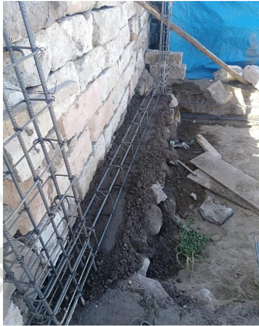
Figura 8 Sobrecimiento Armado
