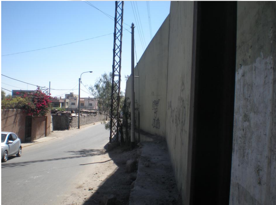
Figura 2.1.2.2 - Rellenos de tierra en dirección al Puente San Isidro
