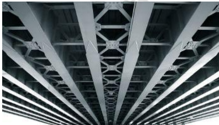
Figura 1.5.2.2.5 – Puente de viga de Alma Llena
