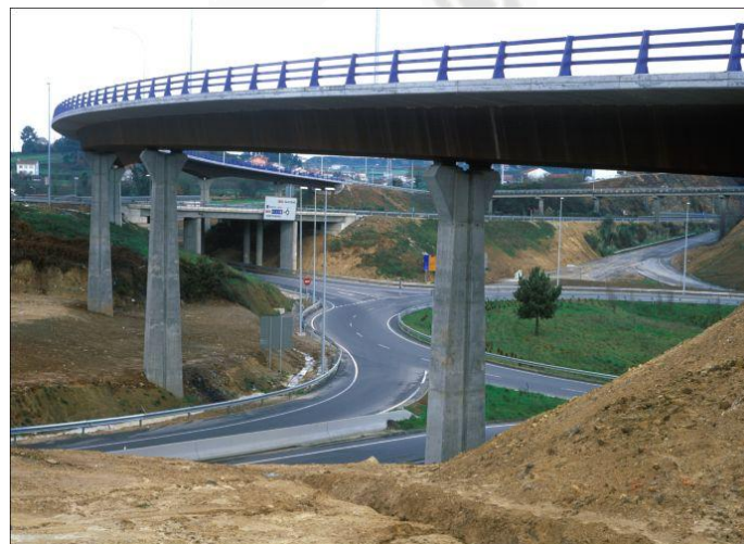
Figura 1.5.2.2.2.3 – Puente de sección cajón
