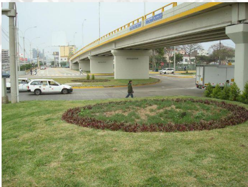
Figura 1.5.2.2.2.1 – Puente de sección viga rectangular
