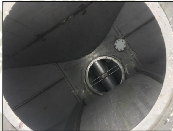
Imagen 41: Interior del estanque de almacenamiento
