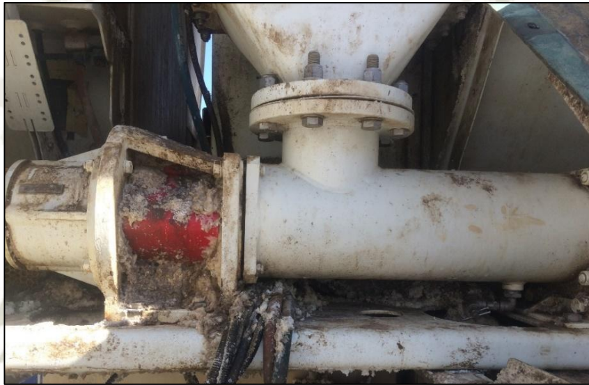
Imagen 54: Sello roto de la bomba de cavidad progresiva
