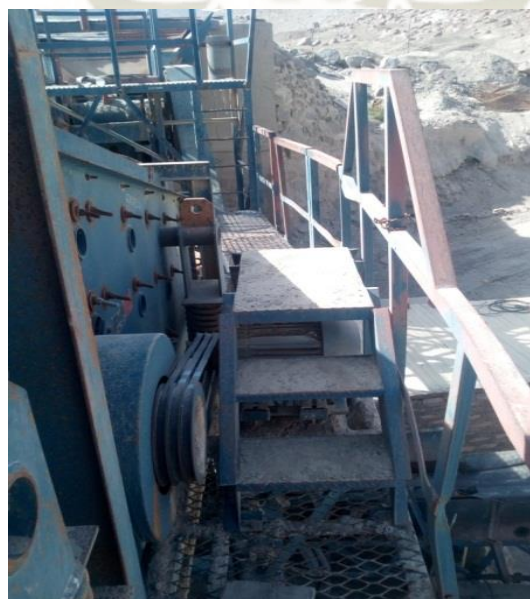
Figura 40. Plataforma de mantenimiento de la Chancadora
