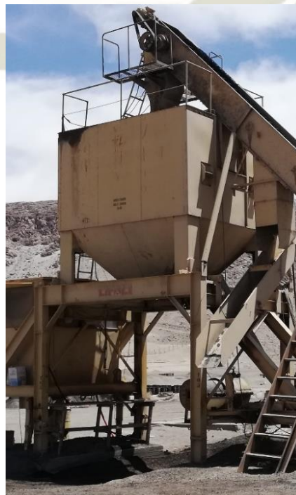
Figura 13. Tanque con Asfalto
