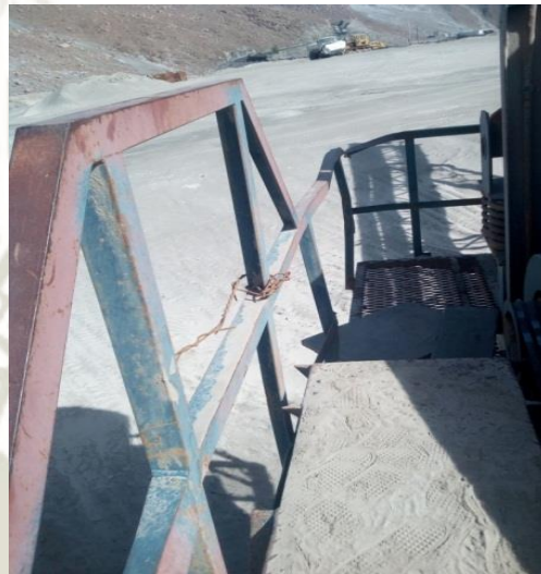
Figura 39. Plataforma de mantenimiento de la Chancadora
