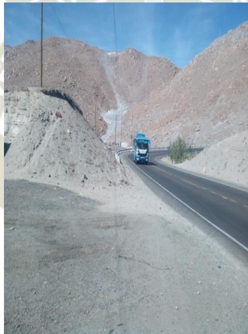
Figura 20. Ingreso principal a la Planta
