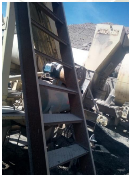
Figura 27. Escaleras Metálicas del Tanque de Almacenamiento de material Asfáltico
