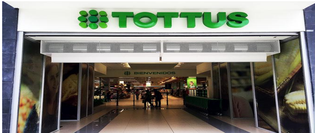
Figura N° 19: Cortina de aire colocada al ingreso de un centro comercial
