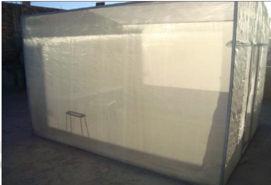
FIGURA 2.1. Invernadero tipo capilla.
