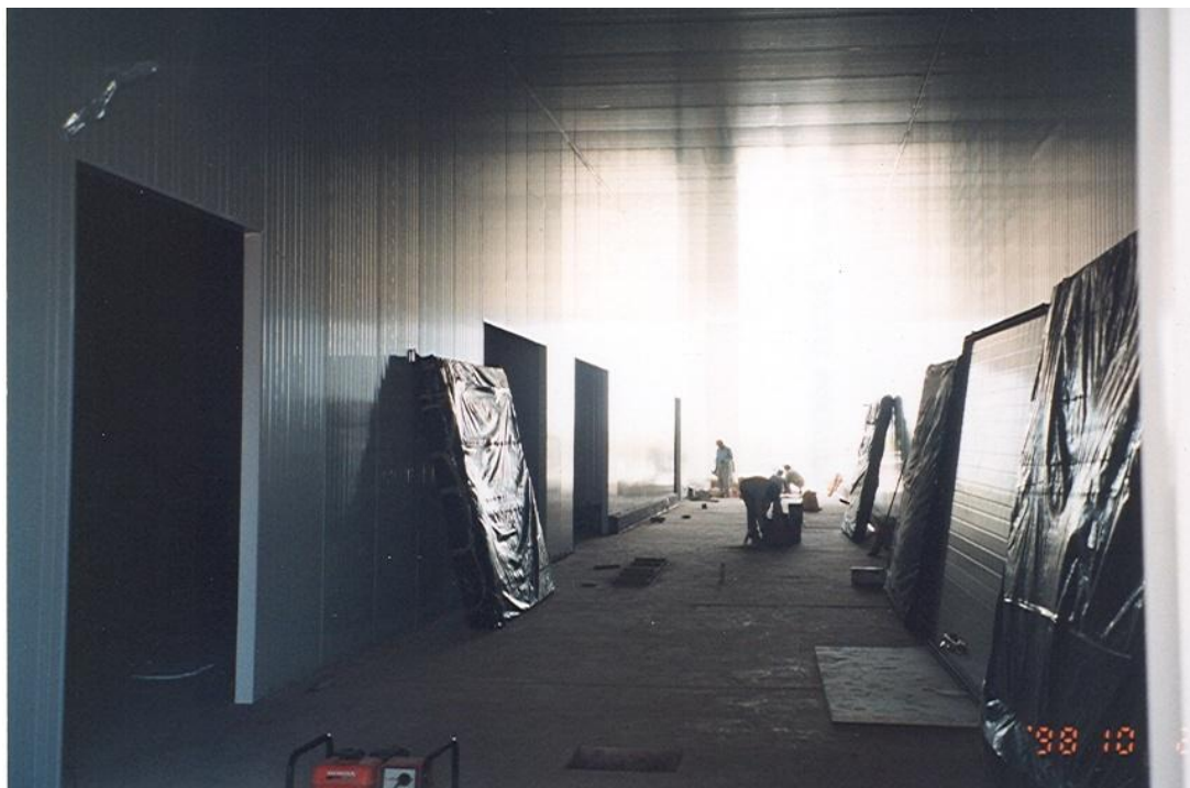
Fig. 22: Cámaras de refrigeración en construcción
