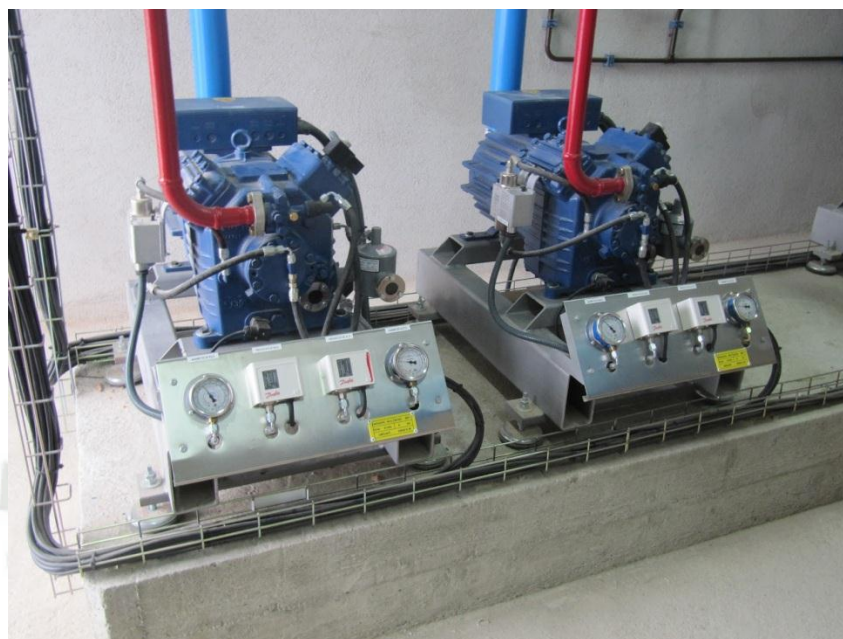
Fig. 31: Compresores semi herméticos en V, mostrando los controles de ciclos como los presostatos.
