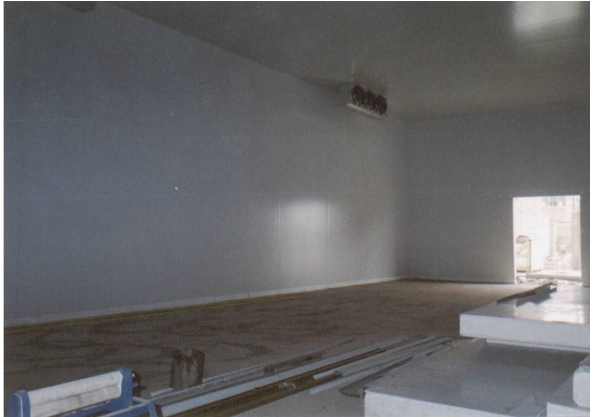
Fig. 28: Construcción de cámaras de almacenamiento de producto refrigerado previamente en el túnel
