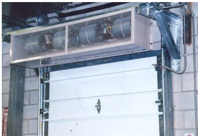
Fig. 36: Cortina de aire mecánica que mitiga las cargas por cambios de aire
