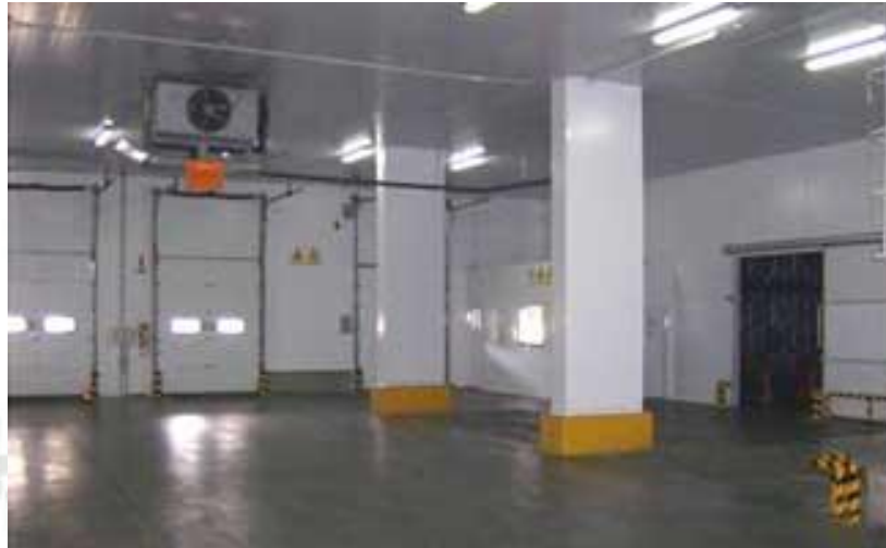
Fig. 63 Muestra la zona de tránsito del túnel hacia las cámaras
