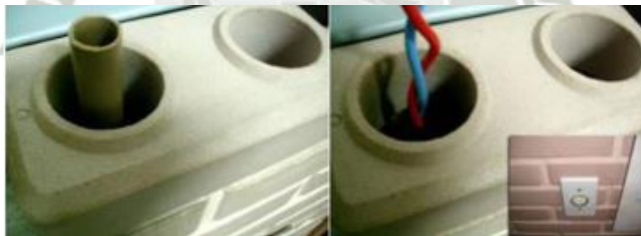
Figura N° 2 INSTALACIONES HIDRÁULICAS Y ELÉCTRICA
