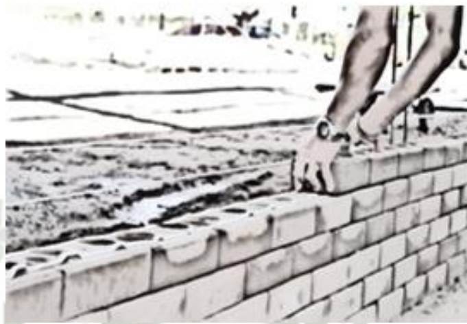
Figura N° 3 MORTERO APLICADO A LOS LADRILLOS ECOLÓGICOS
