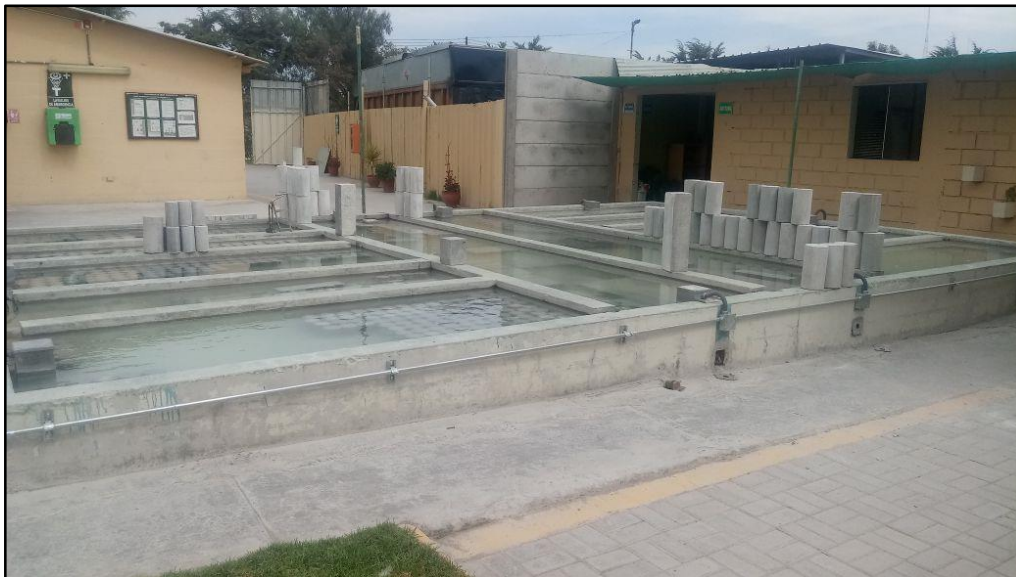
Figura 31. Poza de curado – Laboratorio Supermix.
