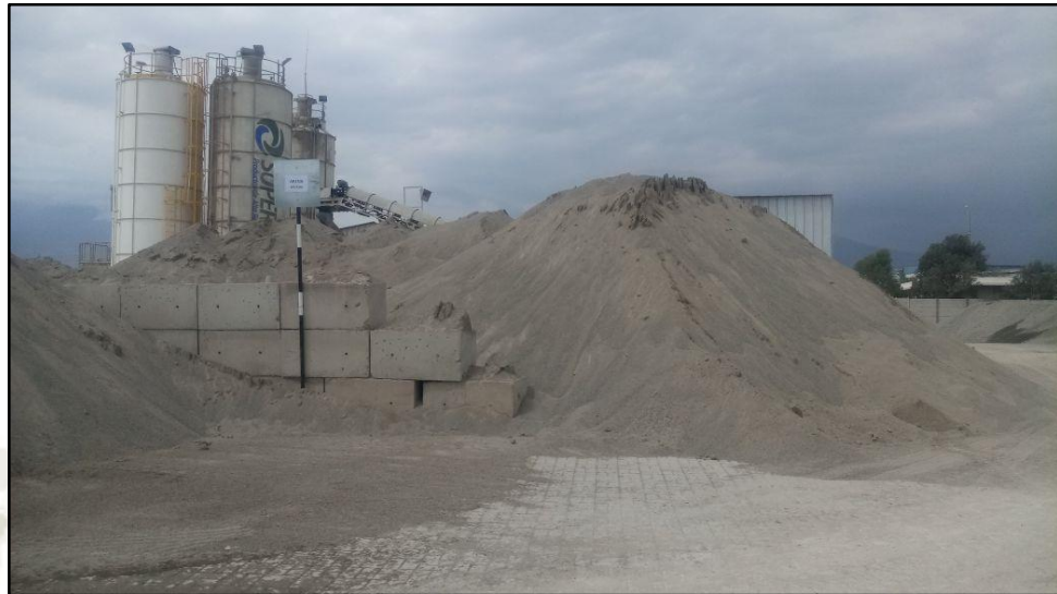
Figura 15. Acopio de arena.
