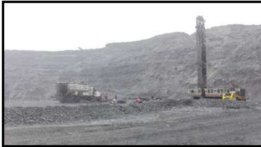
Figura 20. Área de perforación y voladura de mina 4
