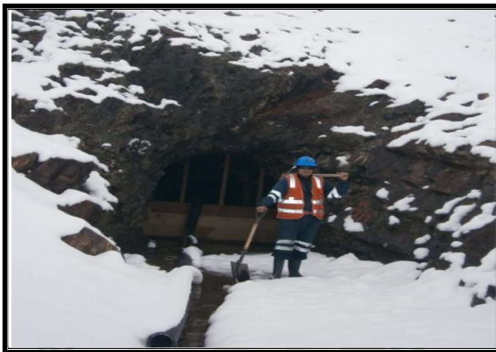
Foto N°1: En la fotografía se muestra la bocamina 02 que será sometida a cierre, cubierta por una de las capas a emplear que será el sustrato que viene a ser una cubierta de glaciár no estratificada.
