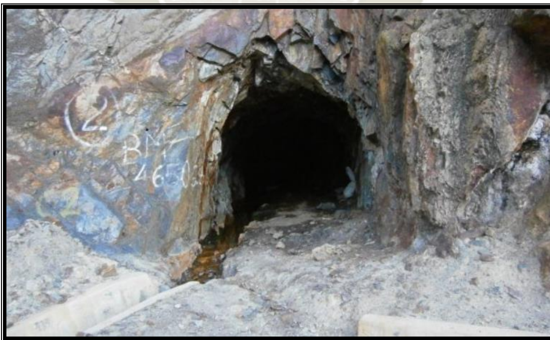
Foto N°6: Bocamina 2 ubicada en el nivel 4650, la cual necesitará una tubería para drenaje.
