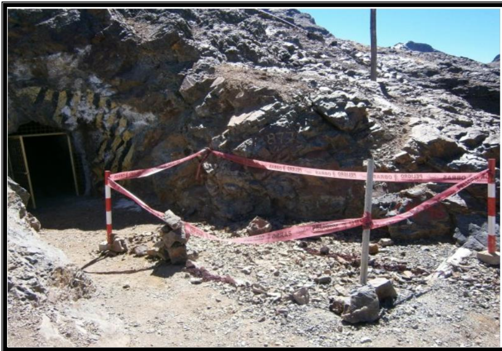
Foto N°3: Habilitación del área para la construcción del tapón y cierre de Bocamina
