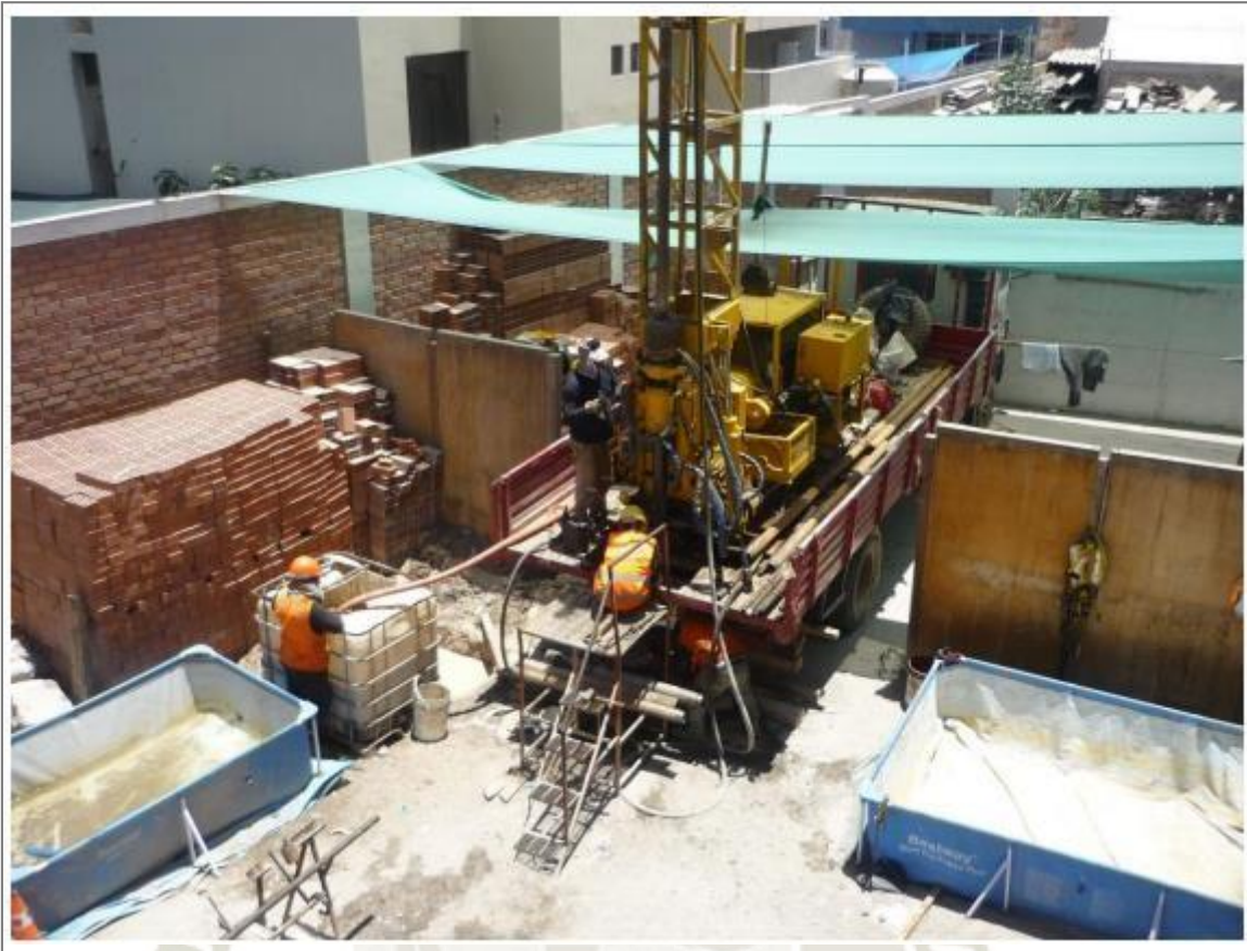
Figura 3.7: Vista de la perforación diamantina en SENCICO, Arequipa
