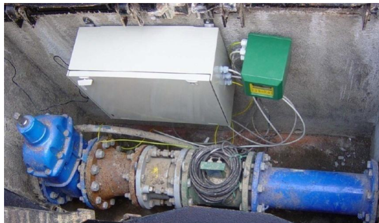
FIGURA No. 164: VISTAS DEL TUBO ELECTROMAGNÉTICO Y LA ELECTRÓNICA ML250 - FLOWIZ
