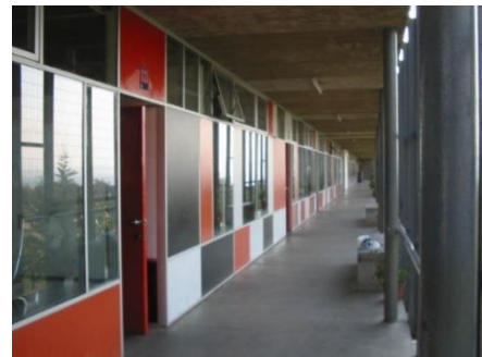
VISTA PASILLOS DE AULAS
