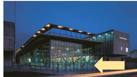
VISTA DE ACCESO PRINCIPAL
