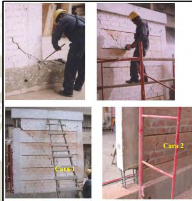
Figura 14: Picado en las columnas y ranurado de las juntas horizontales
