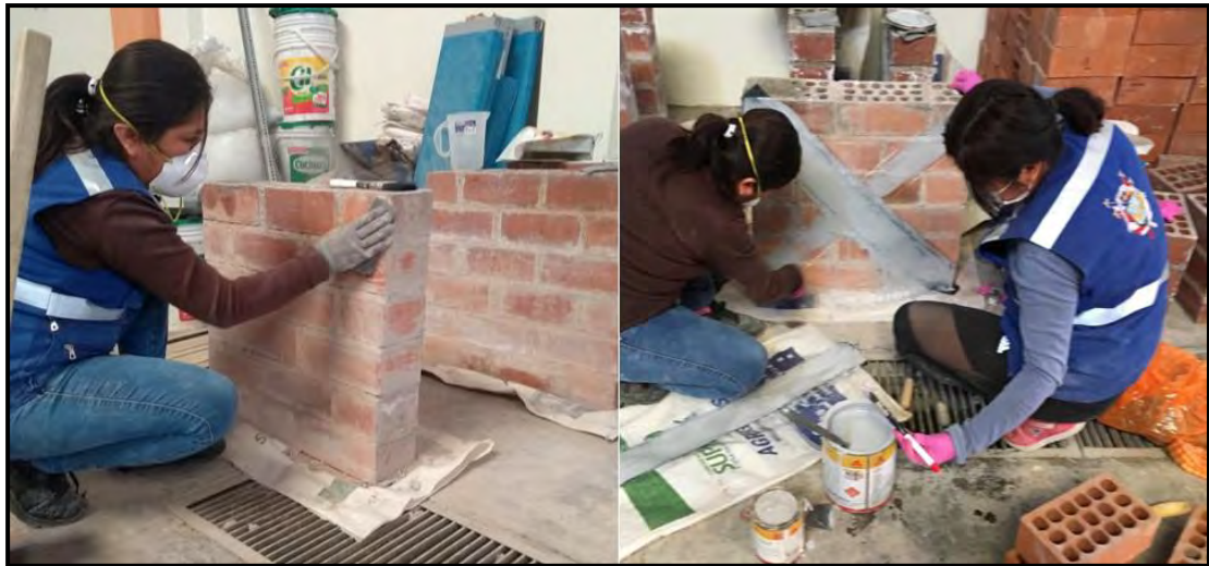
Figura 56: Limpieza y colocación de fibra de carbono
