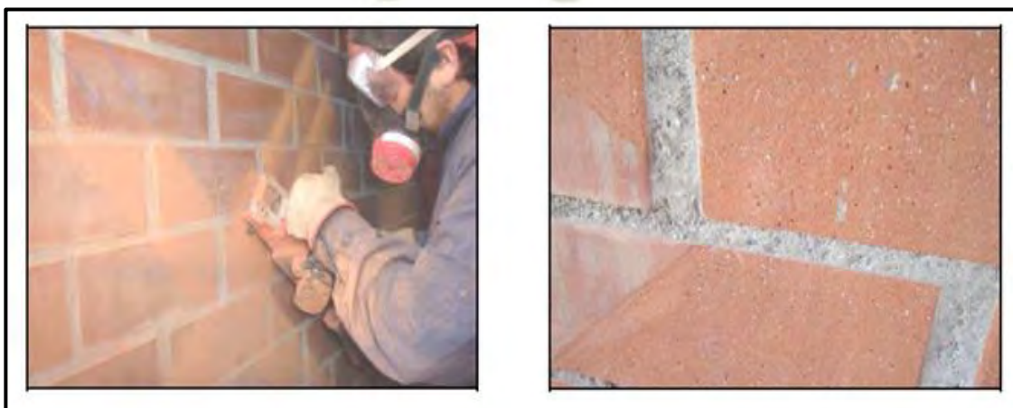
Figura 24: Tratamiento superficial en los paños de albañilería terminados
