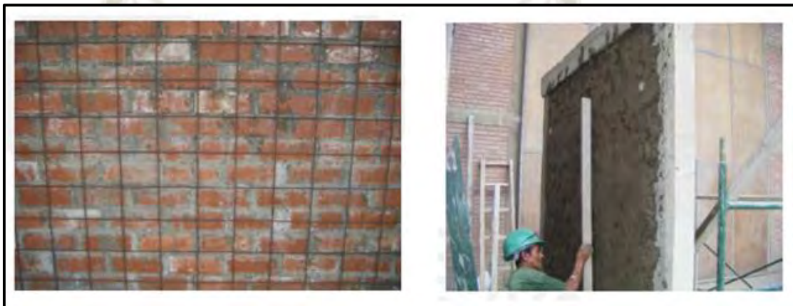
Figura 20: Reforzamiento con malla electrosoldada y tarrajeo del muro
