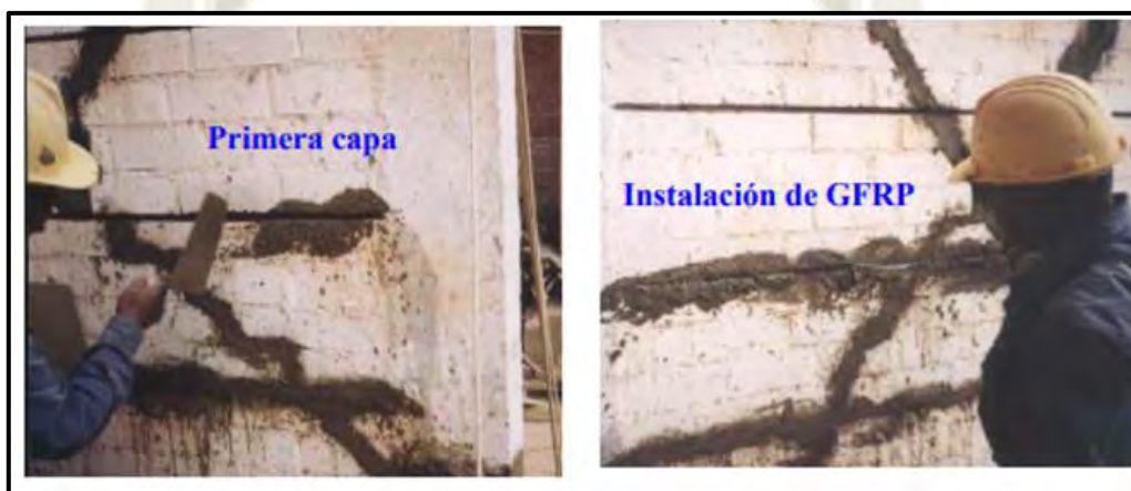
Figura 17: Instalación de las varillas de GFRP
