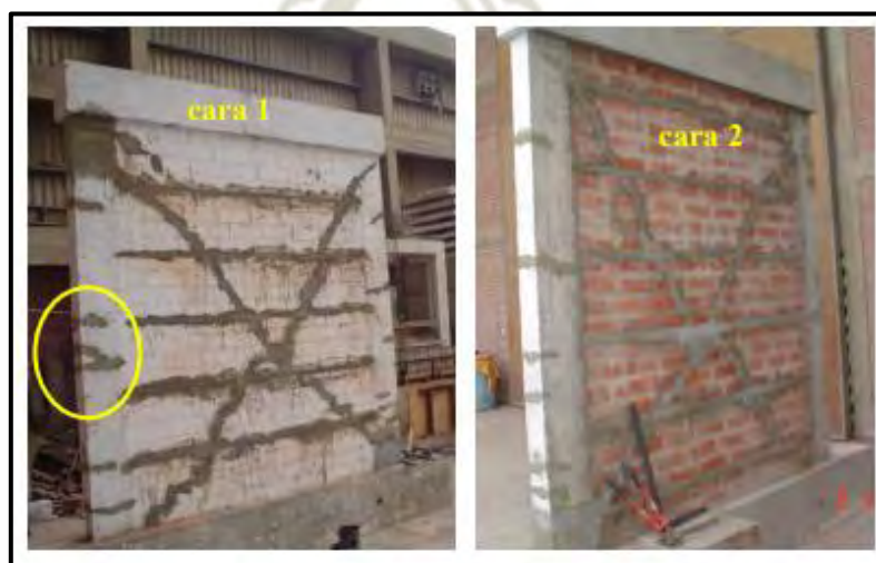
Figura 18: Muro reforzado con varillas de GFRP
