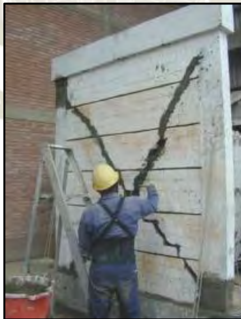
Figura 16: Sellado de las grietas de albañilería
