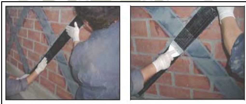
Figura 25: Aplicación de adhesivo y colocación de tela CFRP
