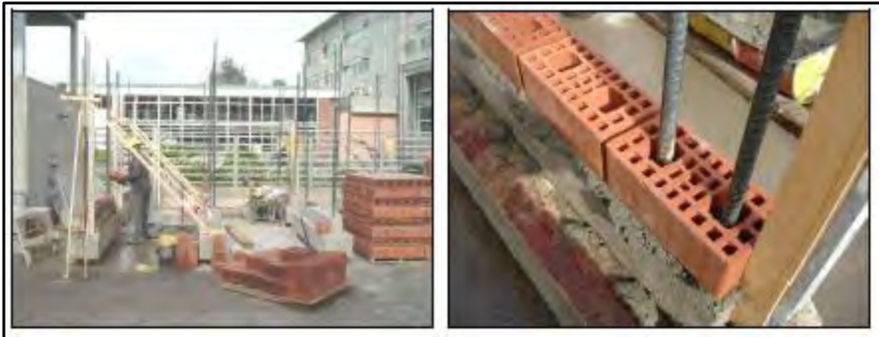
Figura 23: Bases de hormigón y de armadura de borde
