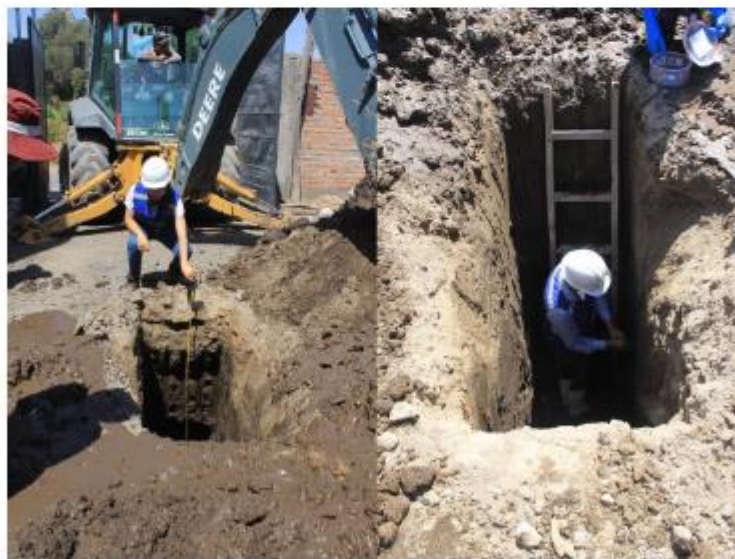
Foto 4 Calicata 4 en el C. P. El Pasto. Fuente: Toma propia
