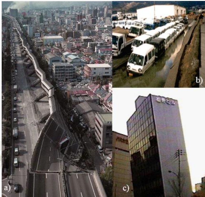
Ilustración 27 a) Colapso de los pilares de la autopista de Hanshin. b) Deslizamiento lateral y hundimiento del pavimento. Fuente: ( Johansson, 2000) c) Inclinación del edificio debido a fallos del terreno por licuación Fuente. (Tupak, 2009)
