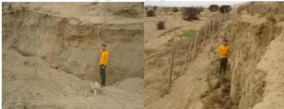
Ilustración 40 Desplazamiento vertical producto del desplazamiento lateral del terreno en Canchamaná. Fuente: (Rodríguez-Marek, y otros, 2007).
