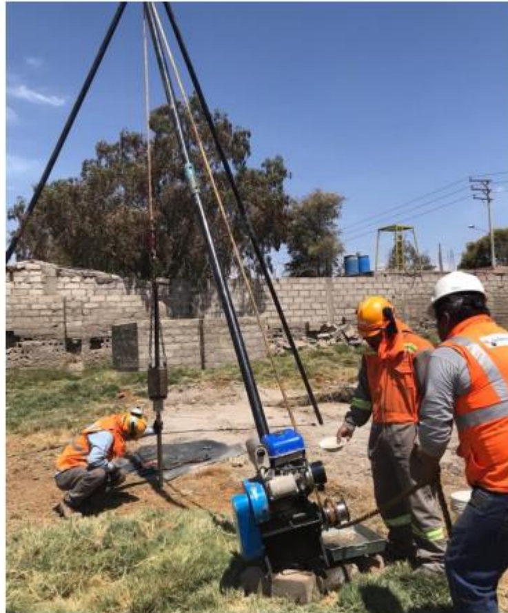
Foto 23: Realización del ensayo SPT. Fuente: Toma propia
