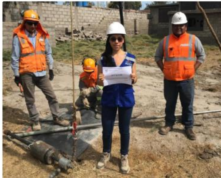
Foto 20: Ensayo de Penetración Estándar N°03 Fuente: Toma propia
