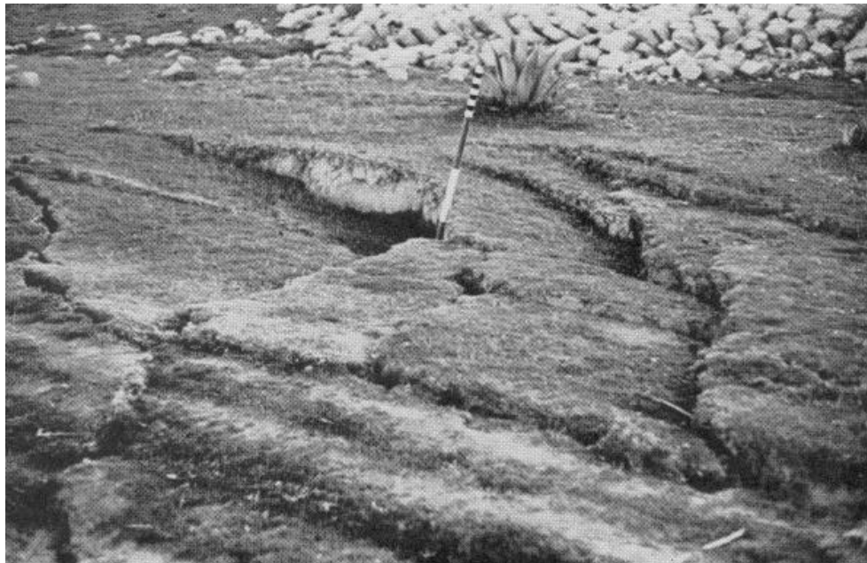
Ilustración 32 Desmoronamiento y fisuración en un campo de regadío en el valle de río Santa, cerca de Yungay. Fuente (Ericksen, Plafker, & Fernández-Concha, 1970).
