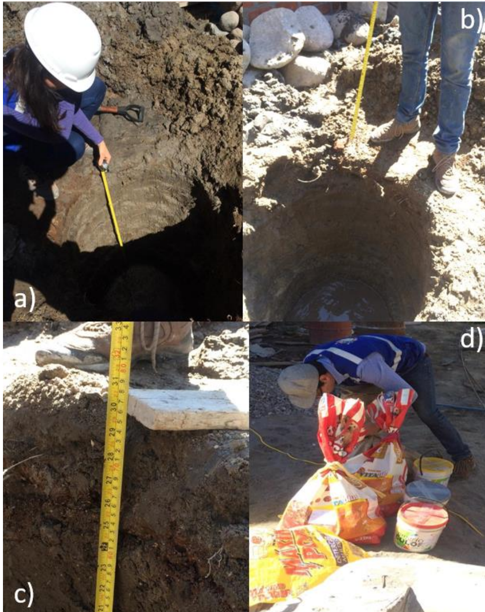
Ilustración 6a) Calicata de exploración en el C. P. El Pasto b) Profundidad total de 3m c) Medición del nivel freático establecido en 0.78 m d) Toma de muestras. Fuente: Propia.
