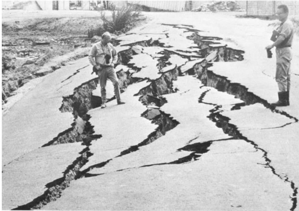
Ilustración 35 Desmoronamiento y fisuración de la carretera cerca de la costa de la bahía en el oeste de Chimbote debido a la licuefacción y la expansión lateral de los sedimentos. Fuente (Ericksen, Plafker, & Fernández-Concha, 1970).
