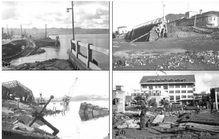
Ilustración 30 Efectos de licuación en el terremoto de Chile. Fuente (Kurt Grassau por Parra 2008).
