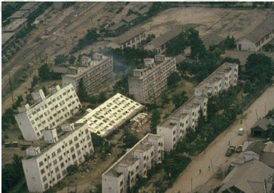
Ilustración 22 Colapso de edificios de apartamentos en Kawagishi-cho (Cortesía de T. Mikumo).
