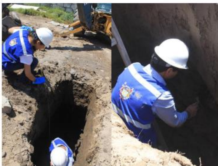
Foto 2 Calicata 2 en el C. P. El Pasto. Fuente: Toma propia.
