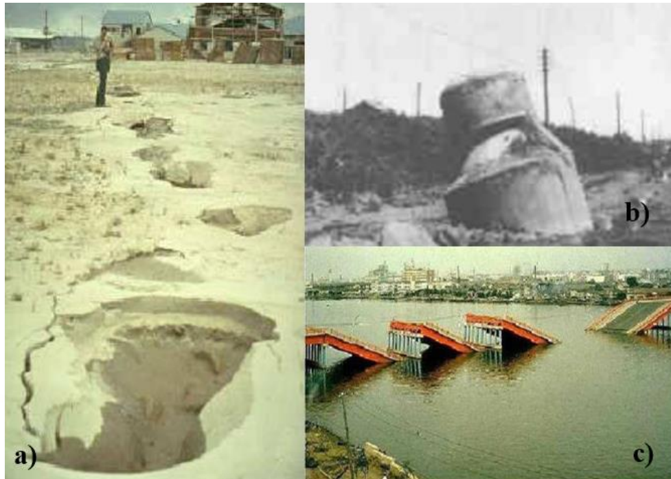
Ilustración 23 a) Volcanes de arena y fisuras en el terreno. Fuente (Parra, D., 2008). b) Buzón flotante como resultado de la licuefacción después del terremoto en Niigata, Japón. Foto: D.B. Ballantyne. c) Falla del puente de Showa. Fuente: (Bhattacharya, y otros, 2014)
