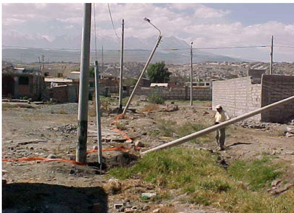
Ilustración 2 Inclinación de postes en el Sector Lara, Socabaya. Fuente (Aguilar Bardales & Alva Hurtado, Noviembre, 2002).
