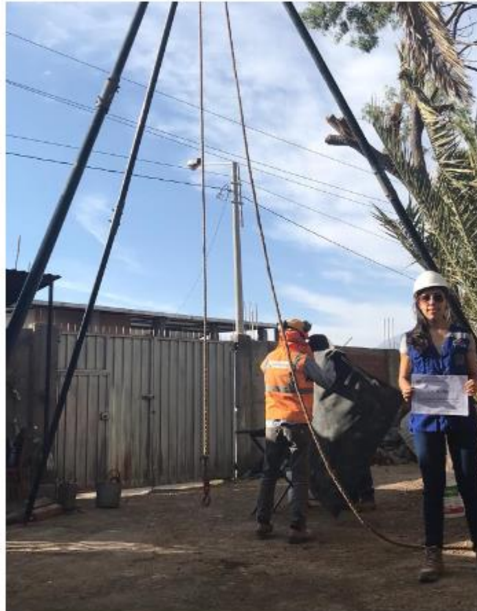
Foto 25: Ensayo de Penetración Estándar N°01 Fuente: Toma propia
