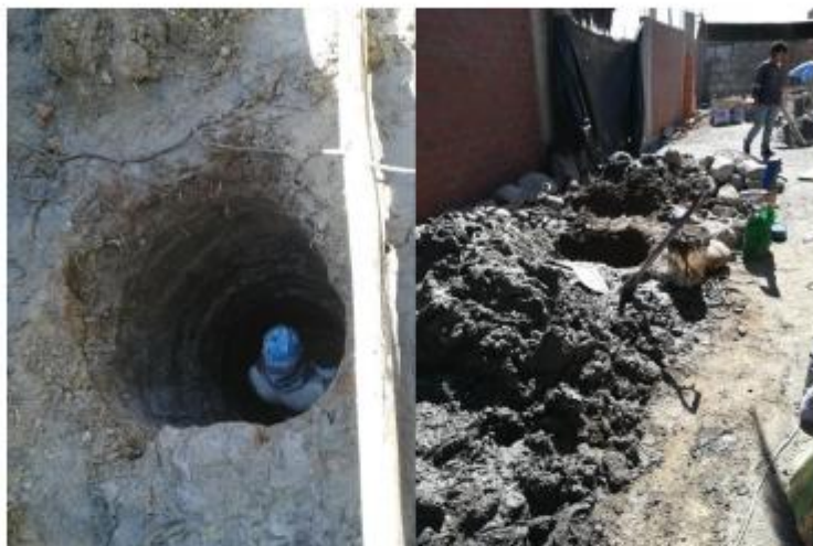
Foto 1 Calicata 1 en el C. P. El Pasto. Fuente: Toma propia.
