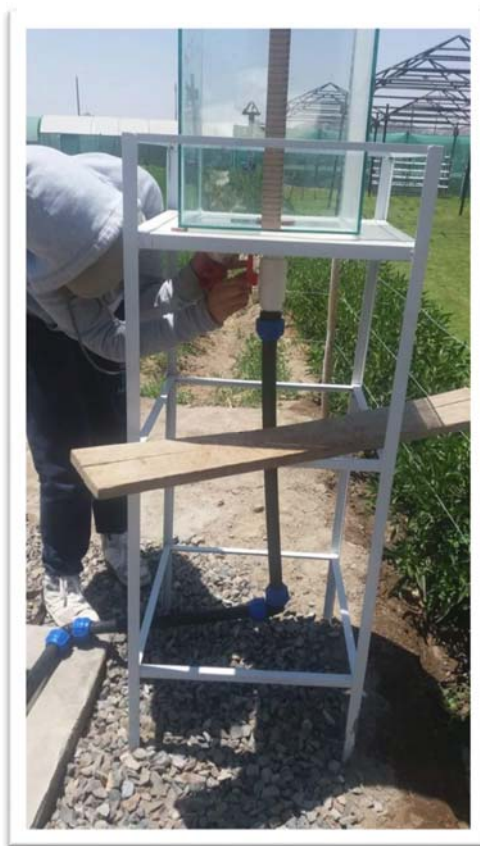
FOTO 8 Instalación del Tanque de Alimentación
