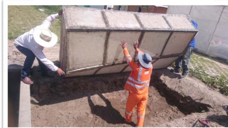
FOTO 6 Instalación de la Caja del Lisímetro
