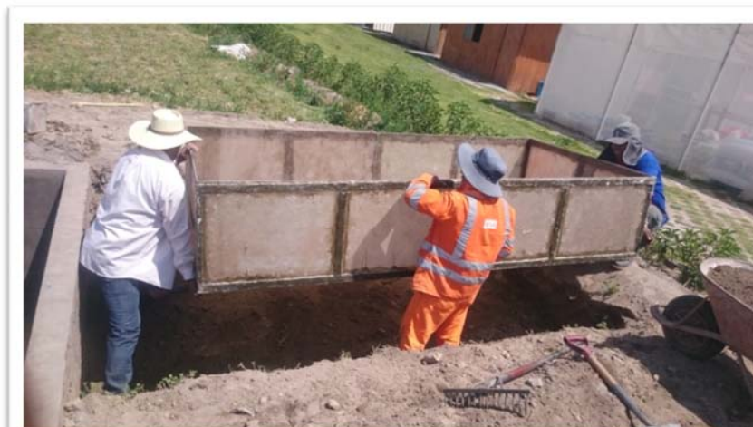
FOTO 7 Instalación de la Caja del Lisímetro
