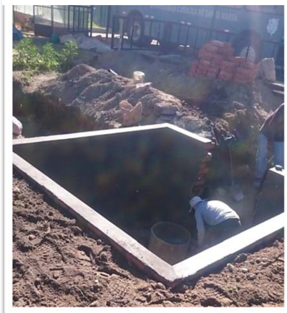
FOTO 5 Construcción de Caseta de Tomas de Datos
