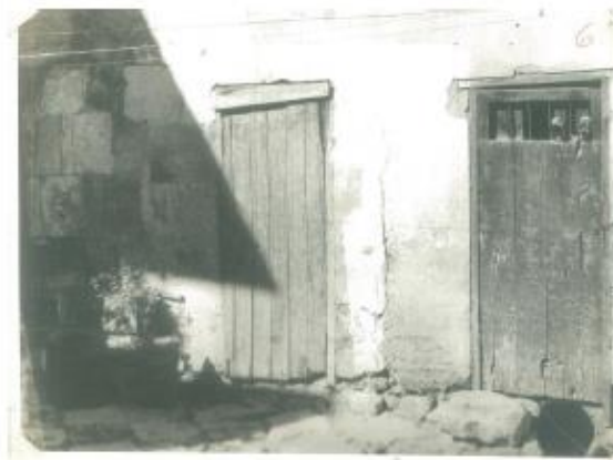
05. OBSERVACIÓN DE LA CARA EXTERIOR DE LA TORRE NOROCCIDENTAL, EN LA PARTE DEL NOROCCIDENTE DE LA TORRE NOROCCIDENTAL.
