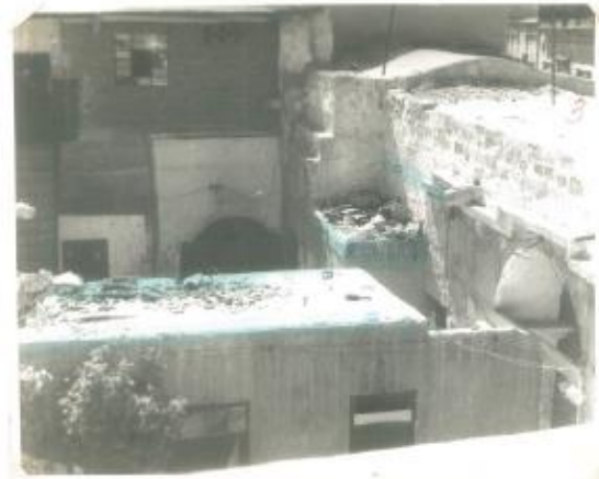
02. OBSERVACIÓN DE UNO DE LOS MÓDULOS QUE SE ENCONTRAN EN LA ZONA DE LA TORRE NOROCCIDENTAL, EN LA PARTE DEL NOROCCIDENTE DE LA TORRE NOROCCIDENTAL.
