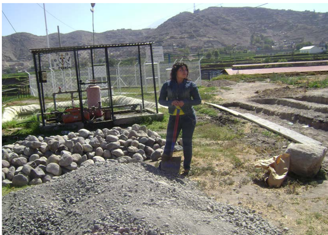
Material para la construcción de las camas
