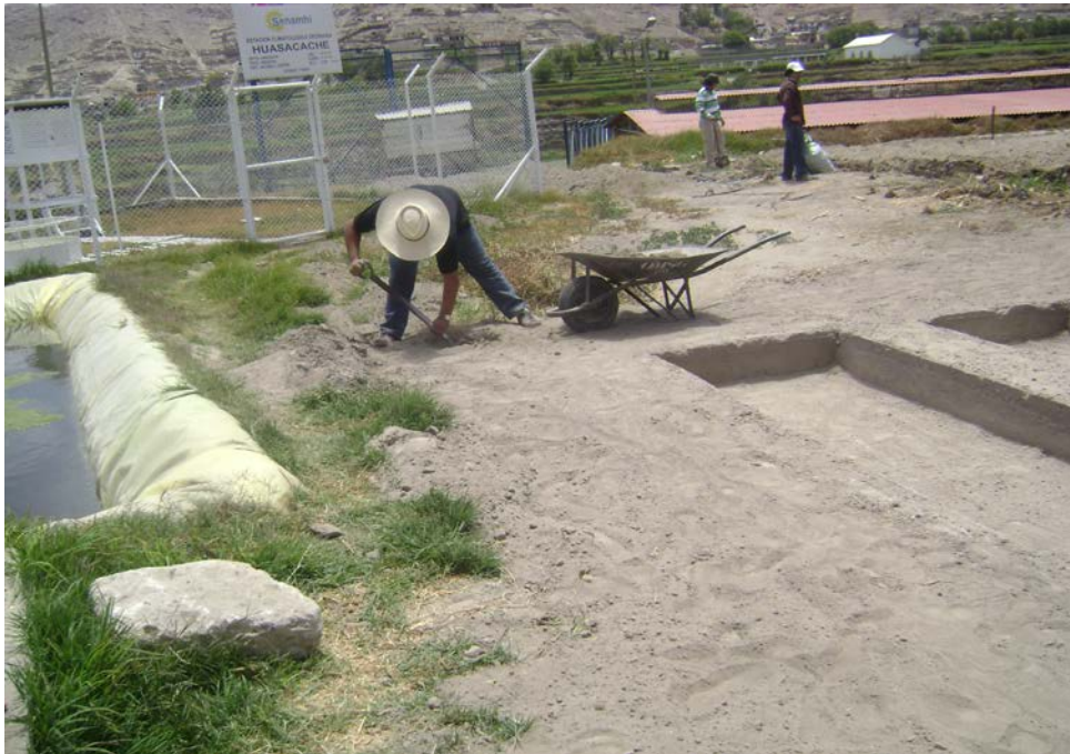
Excavación para Colocación de Postes en el Módulo
