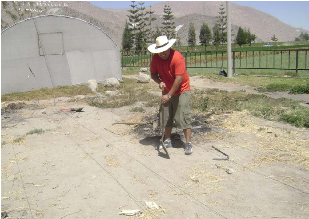
FOTOGRAFÍA No. 2 Limpieza, nivelación y marcado del terreno
