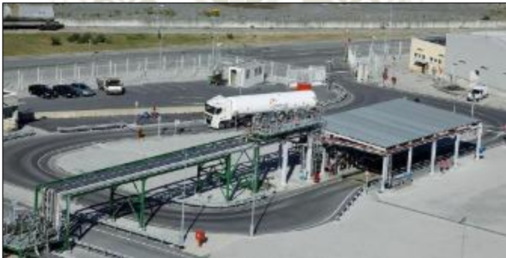
Figura 2.11 Vista de un Cargadero de Cisternas de GNL
