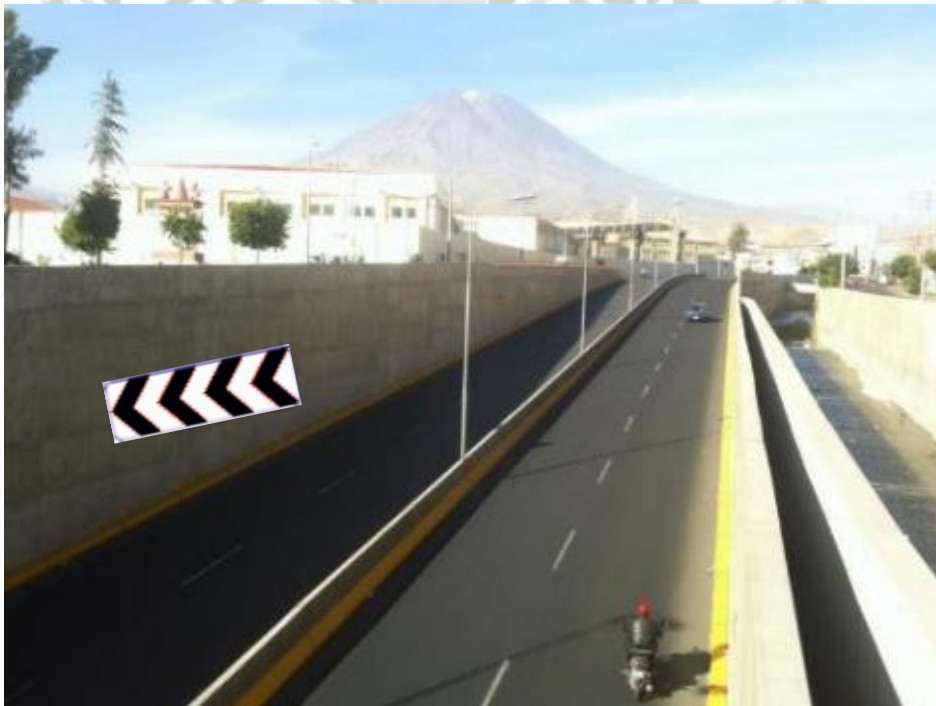
FIGURA 131. SEÑALIZACIÓN DE SENTIDO FUENTE: PROPIA
