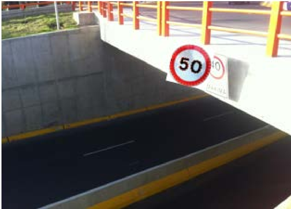
FIGURA 134. MEJORAMIENTO DE LA SEÑALIZACIÓN EN INTERCAMBIOS VIALES FUENTE: PROPIA
