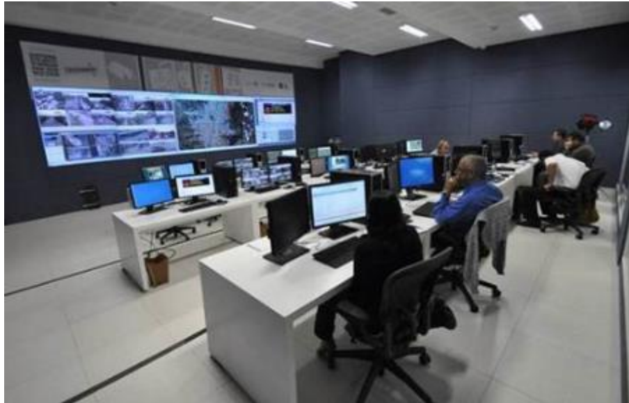
FIGURA 61. CENTRO DE CONTROL FUENTE: WWW.GOOGLE.COM
