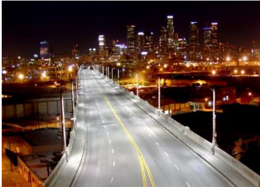
FIGURA 33. ILUMINACIÓN CON LEDS FUENTE: WWW.ESCO-TEL.COM
