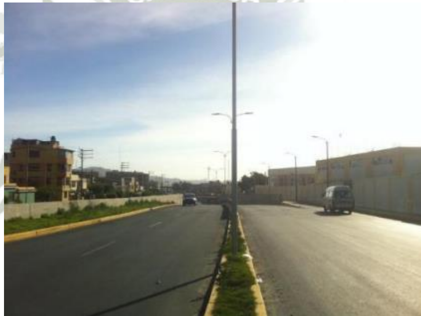
FIGURA 130. FALTA DE SEÑALIZACIÓN FUENTE: PROPIA
