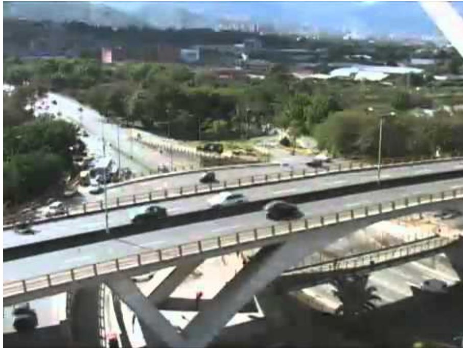
FIGURA 65. APLICACIÓN DEL SISTEMA EN EL PUENTE CHILINA FUENTE: WWW.GOOGLE.COM
