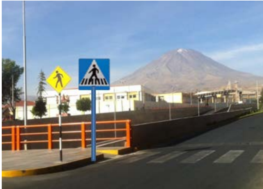
FIGURA 132. SEÑALIZACIÓN DE CRUCERO PEATONAL ELECTRÓNICA FUENTE: PROPIA
