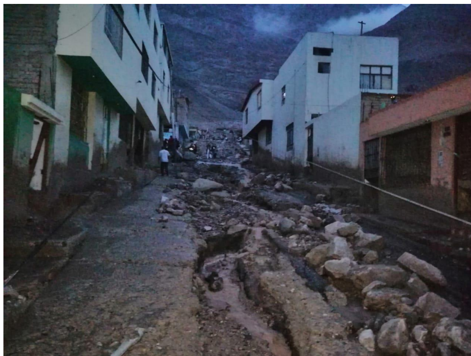
Imagen N° 99 Pista erosionada, en Calle Bolognesi
