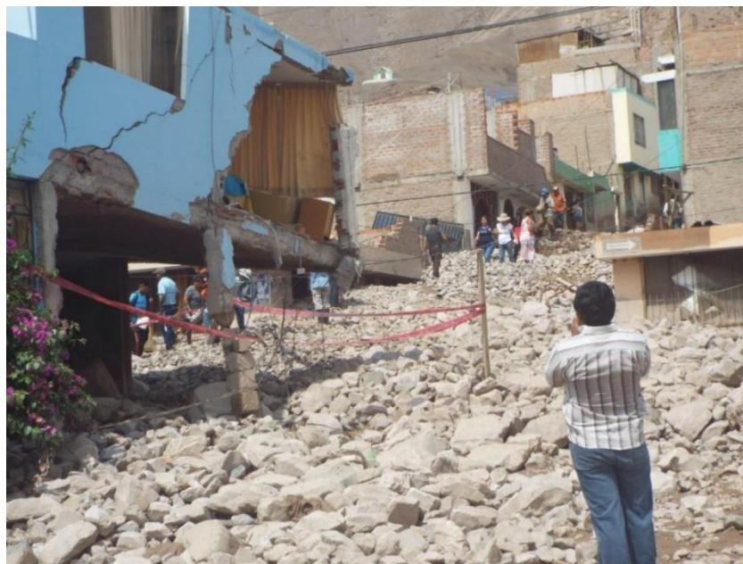
Imagen N° 95 Final Calle Bolognesi, vivienda destruida
