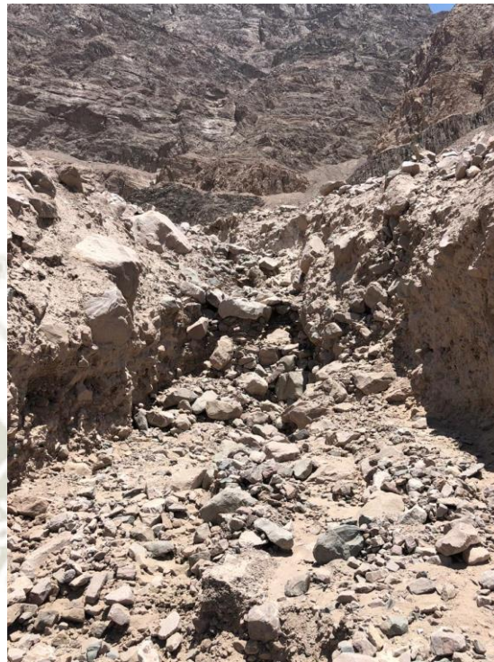
Imagen N° 112 Vista interior del canal- microcuenca baja (altura= 4.3m)
