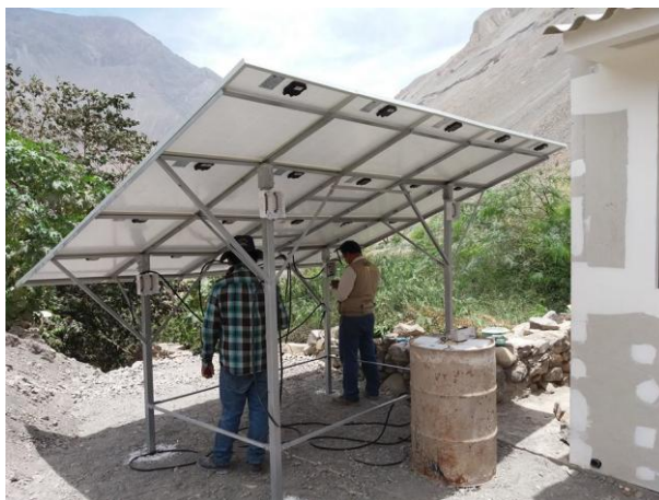
Figura 32 Montaje de los paneles solares en estructuras
