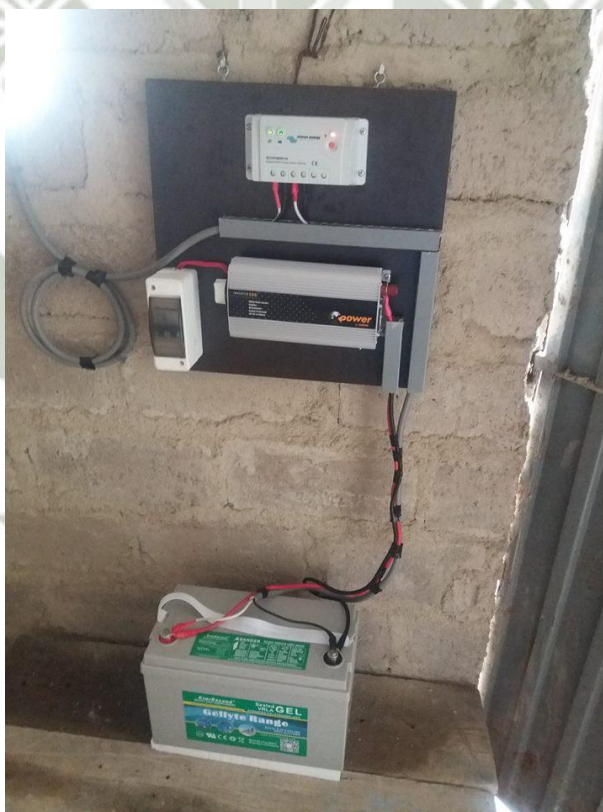
Figura 33 Instalación de los equipos en el interior de la vivienda
